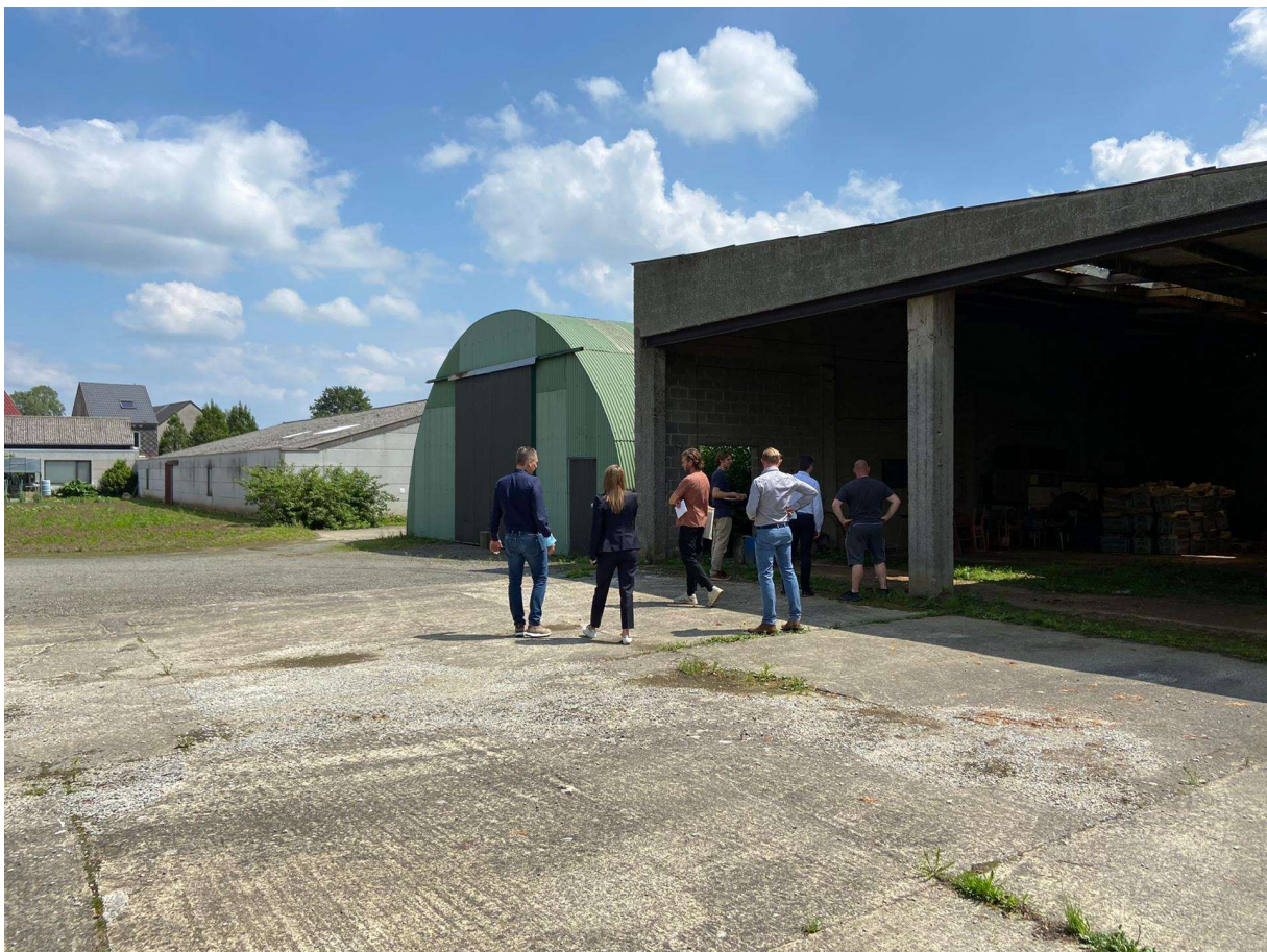
Figuur 10a. Verhardingen met betonplaten, waaronder het warmtenet ligt. ©LARES
