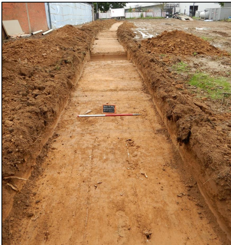
Figuur 17 Overzichtsfoto sleuf 1.
