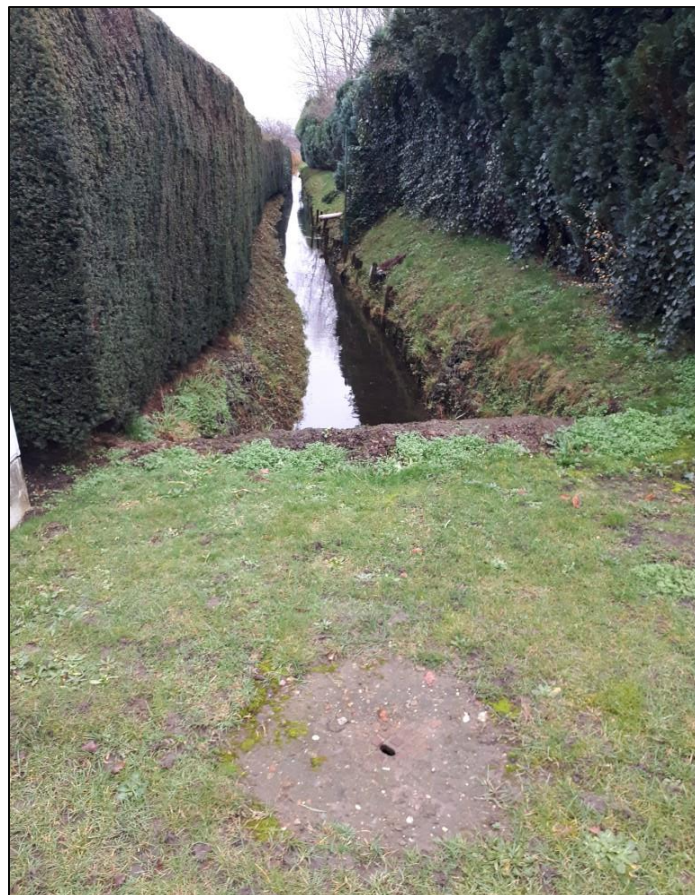
Figuur 7: Foto van de werkzone ter hoogte van de Sint-Niklaasstraat 186. De werkzone wordt voorzien langs beide zijden van de bestaande Schuilhoekbeek.
