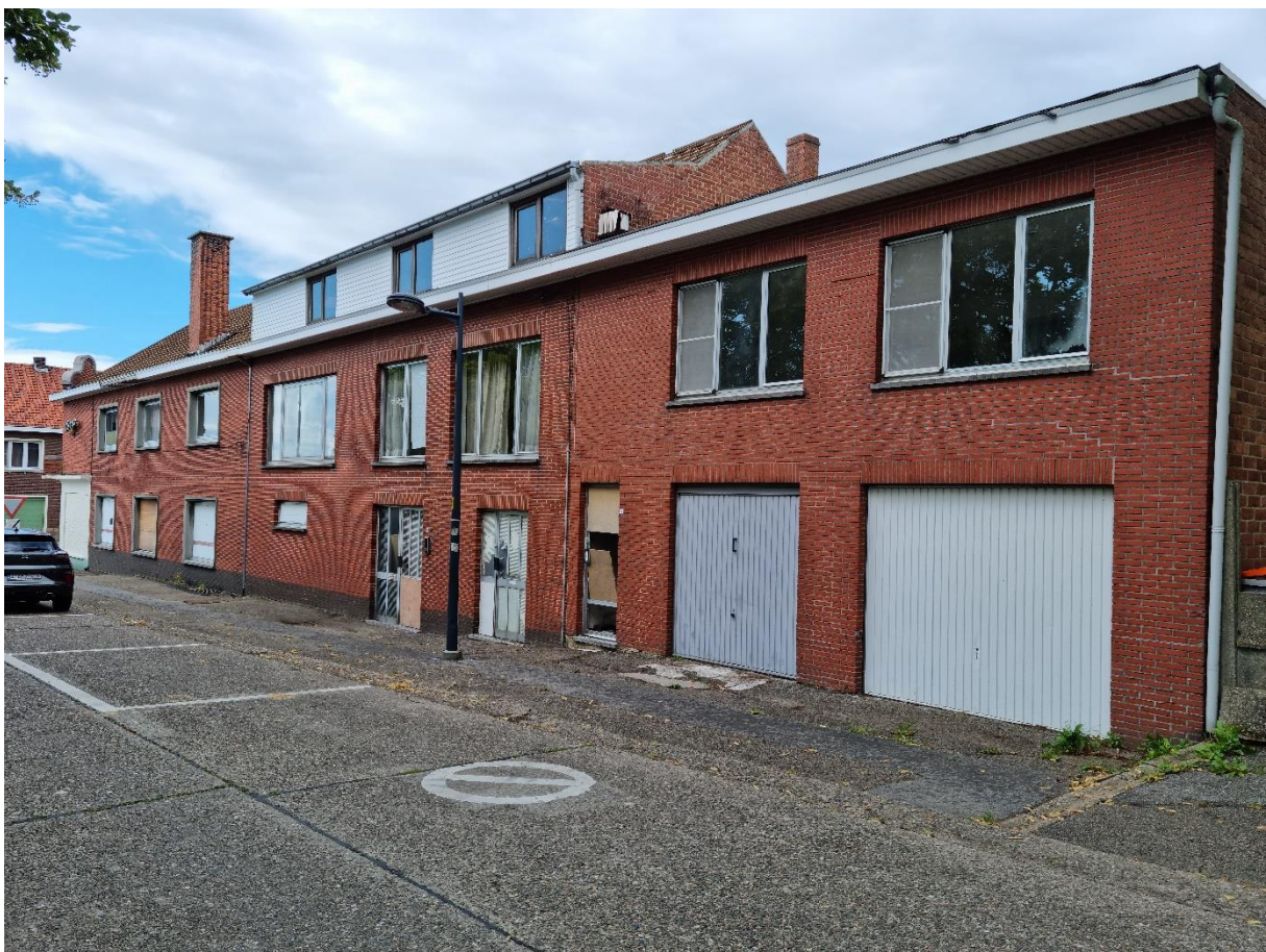
Fig. 6: zicht op het af te breken pand aan de Kerkstraat
