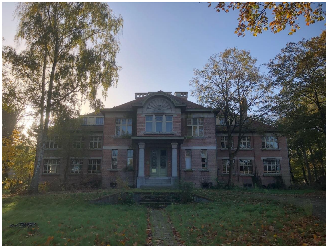
Figuur 6: Zicht op de noordelijke zijde van de bestaande bebouwing
