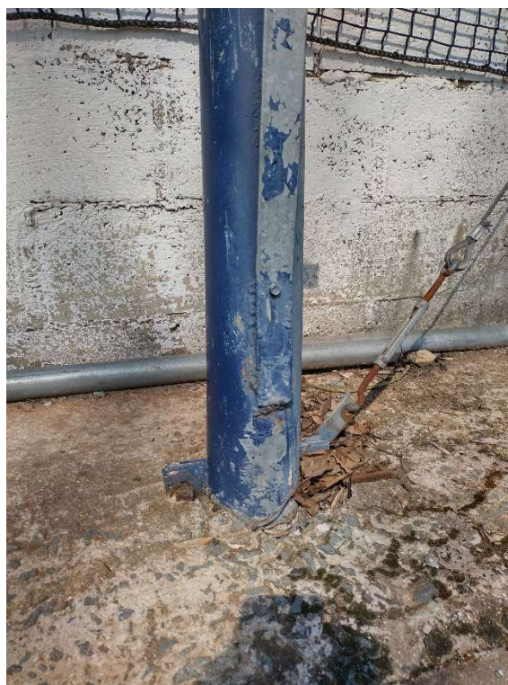
Figuur 4: Zicht op de huidige tennisvelden met detail van de verankering van de overkapping.
