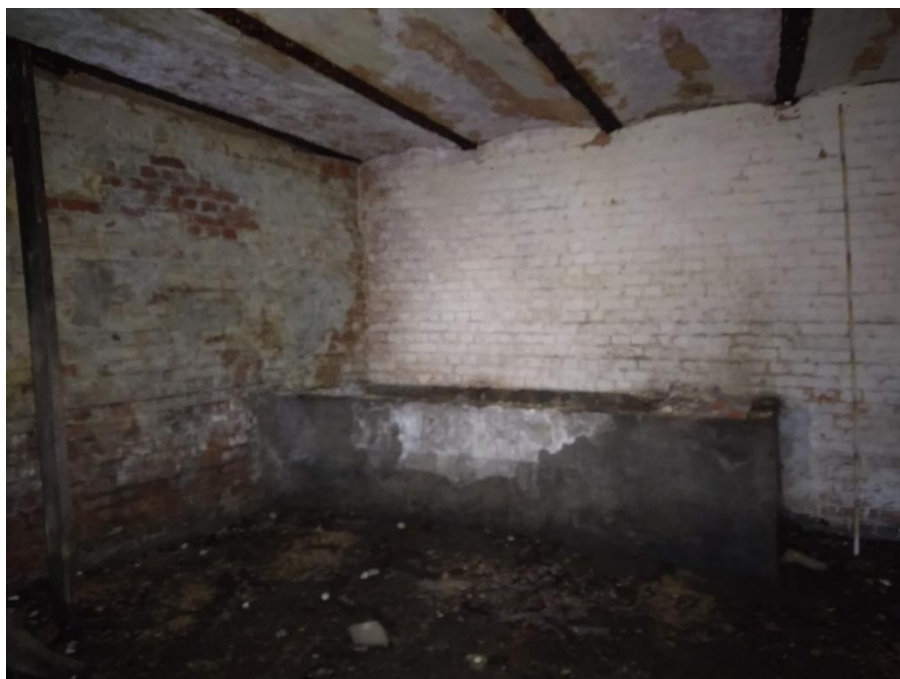
Figuur 6: Foto's van noordoostelijke kelder (© J. Verrijckt)
