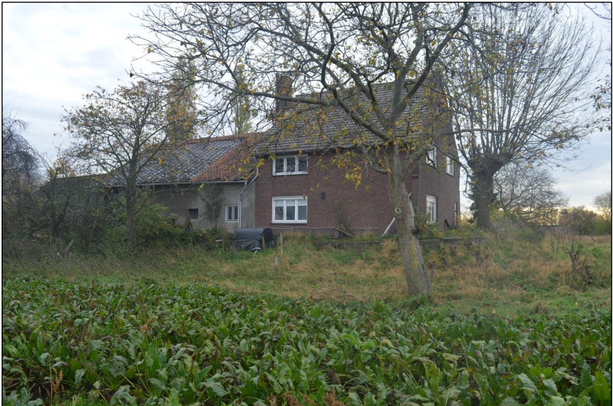
Afb. 17: Hoeve de Krauw, foto van uit westen (Bron: Aron bv, digitaal, 2019A284).
