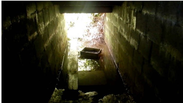
Figuur 7. Zicht op de "bunker" en de toegang tot de tunnel (links onder op de foto). Onder: dezelfde toegang aan de binnenzijde van de tunnel.
