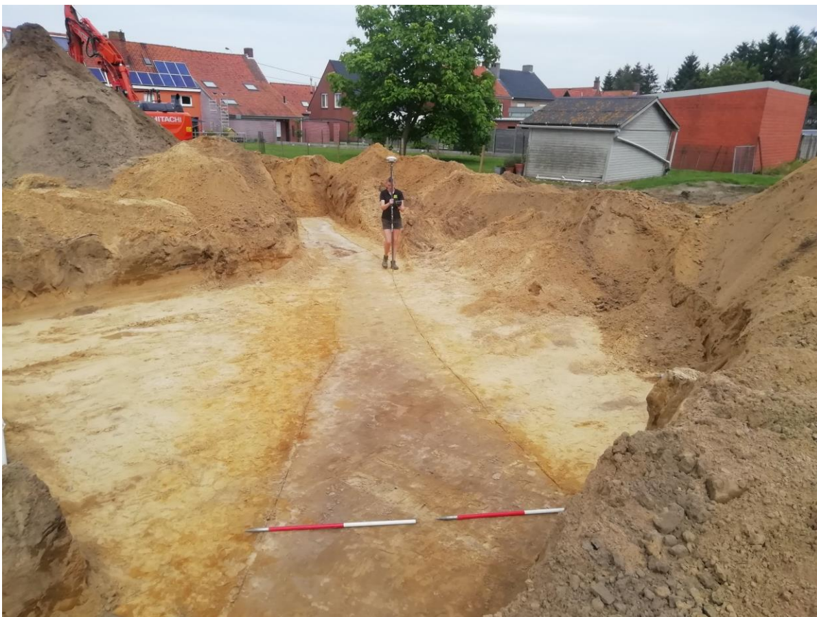
Figuur 10: Inmeten van S12 ter hoogte van het kijkvenster.
