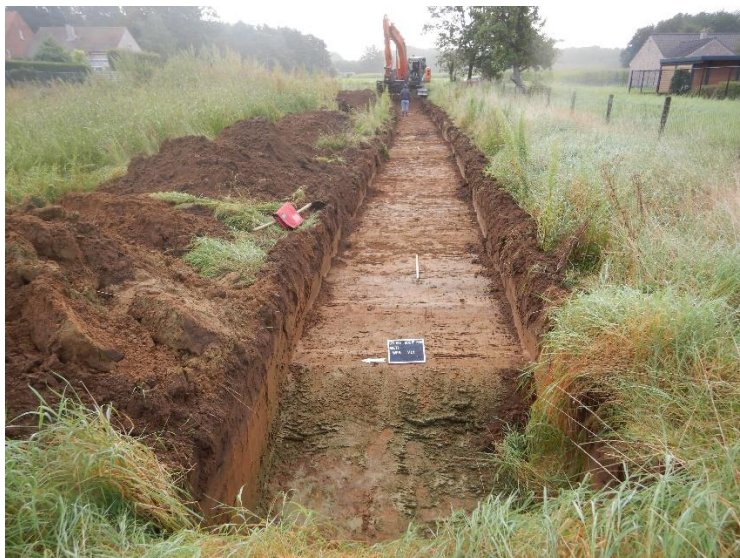
Figuur 17: Overzichtsfoto werkput 5 (© ARCHEBO bvba, 2021).
