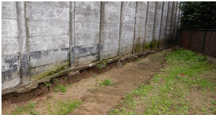
Figuur 11. Noordelijke vlasschuur. Bemerk de afgraving tussen de schuur en de aanpalende tuinen. Onder: de sleuf langs de funderingszolen.
