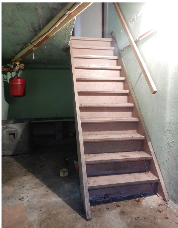
Figuur 14. De kelder onder de woning.
