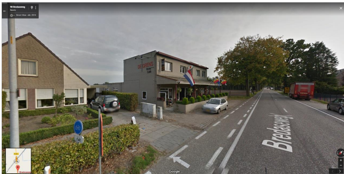
Figuur 4: Hotel en Café 'De Grens' aan de Bredaseweg 98 (Google Street View, 2017)
