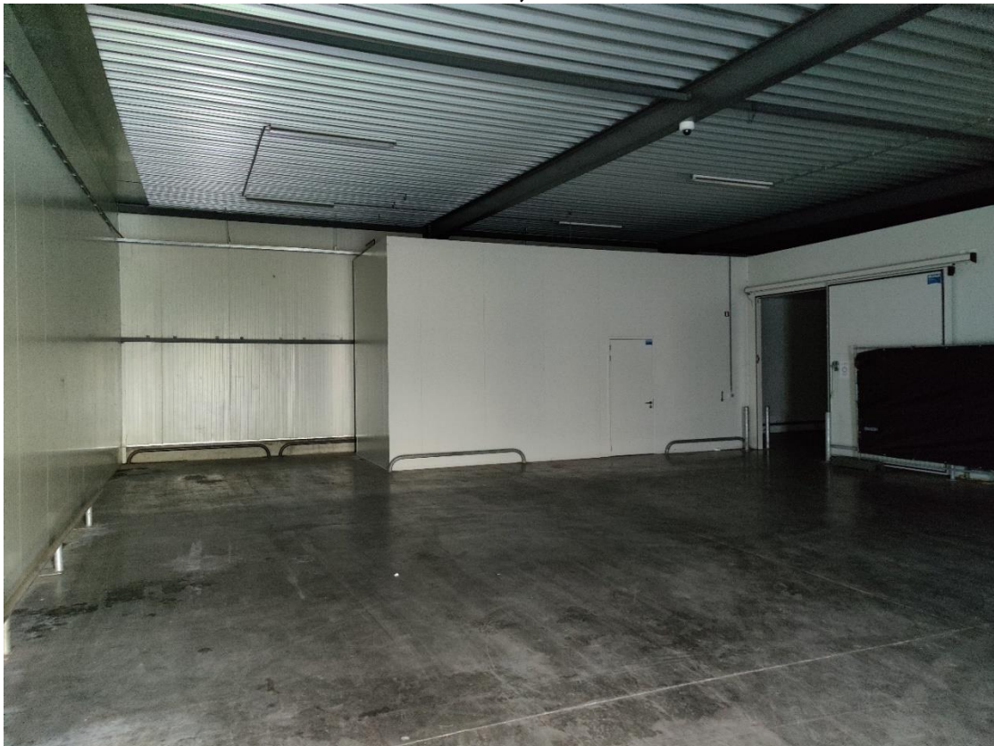
Figuur 8: Zicht op de binnenkant van één van de loodsen. De vloer bestaat uit gepolierde beton (ABO 2021).
