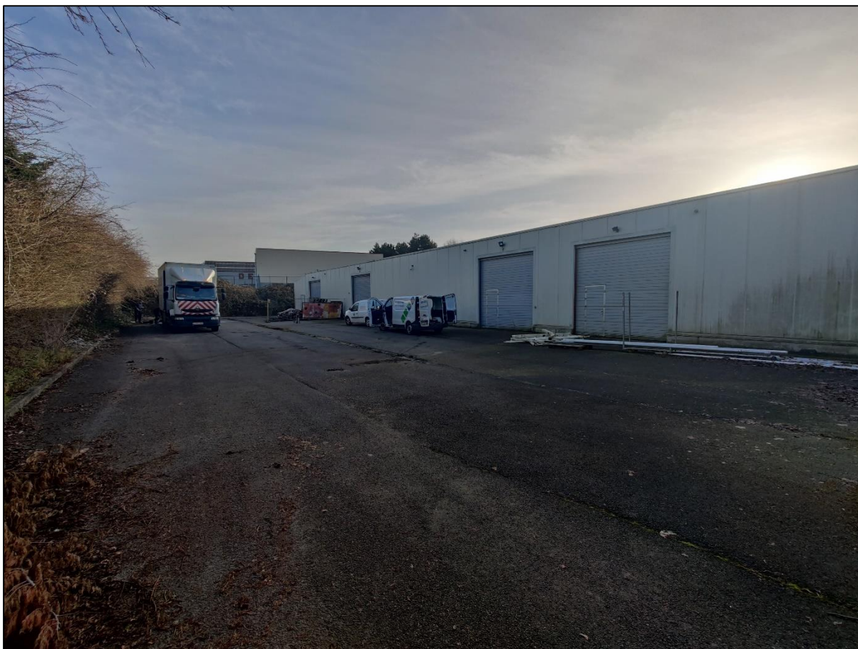
Figuur 44: Terreinfoto, genomen op 25 februari 2021, aan de loods van de Engelse Wandeling nr. 11 (ABO nv 2021).
