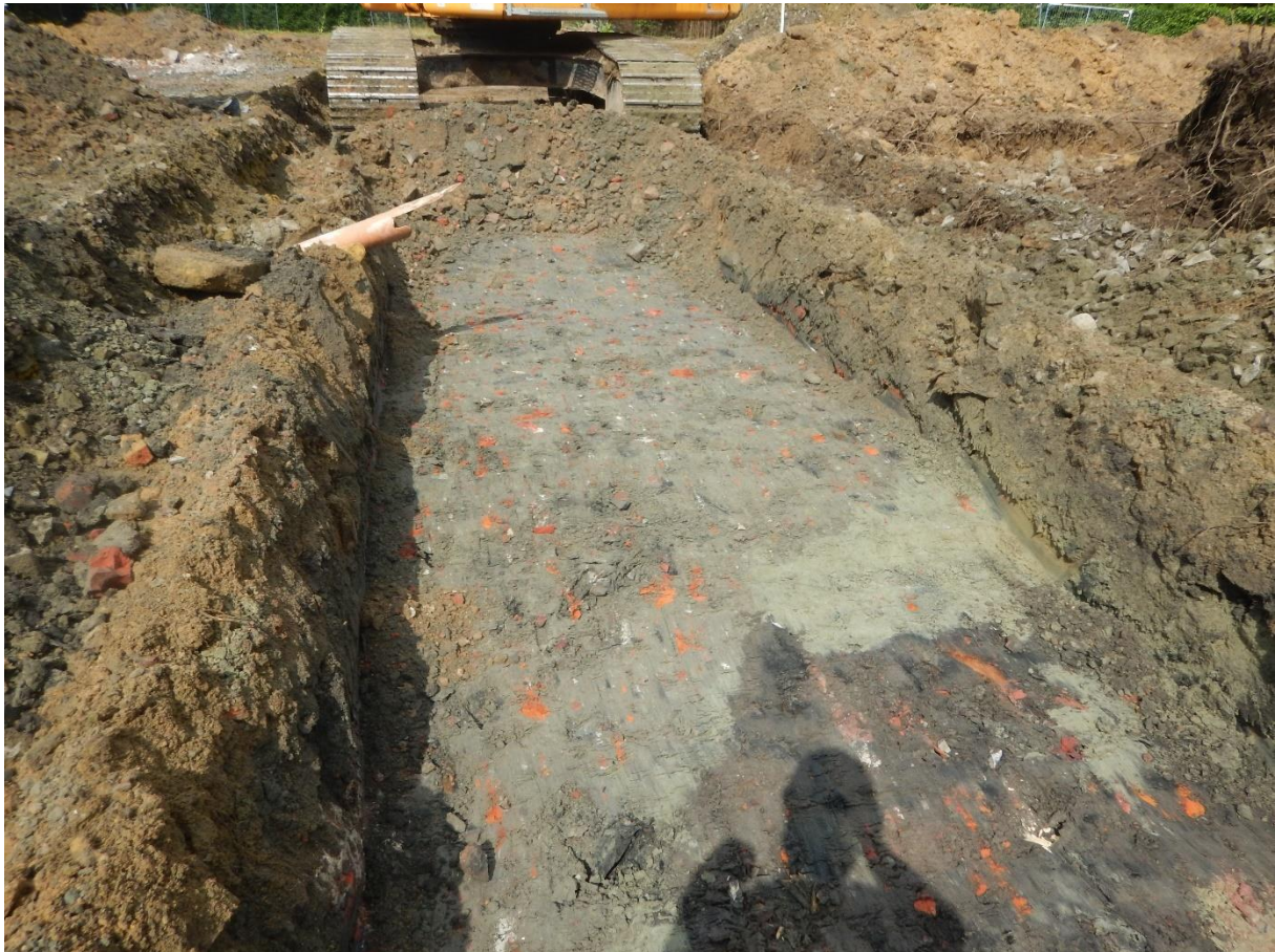
Figuur 35: Zicht naar het oosten toe over de westkant van Sleuf 6 tijdens het afgraven. (©MVDK)
