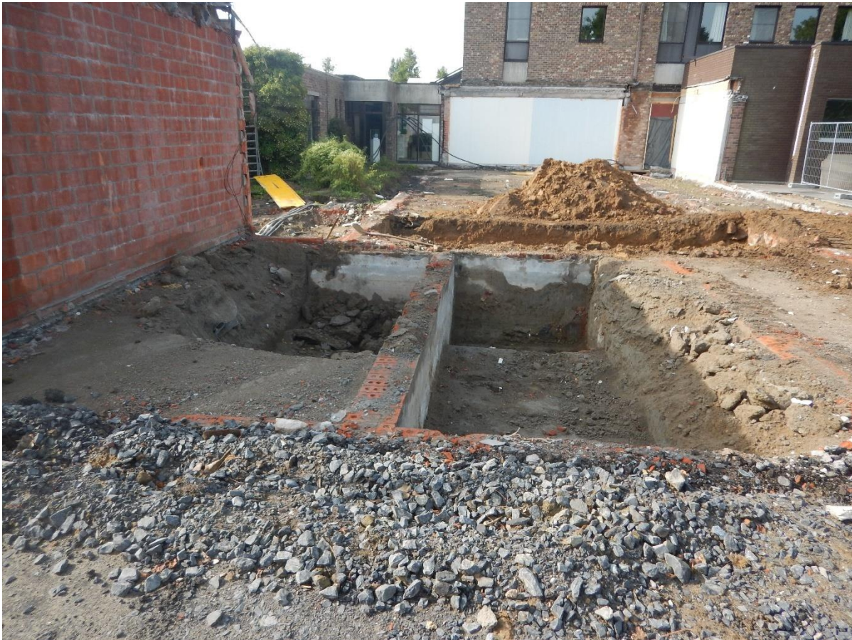
Figuur 14: Zicht naar het zuiden toe met in de achtergrond sleuf 3 (©MVDK).
