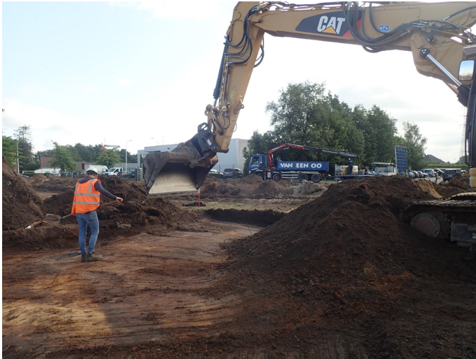
Figuur 11: De archeologen begeleiden de kraan tijdens het afgraven
