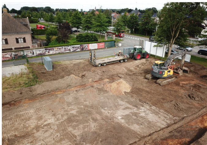
Figuur 13: Noordwestelijk deel van het projectgebied met verharde strook en gesloopte villa
