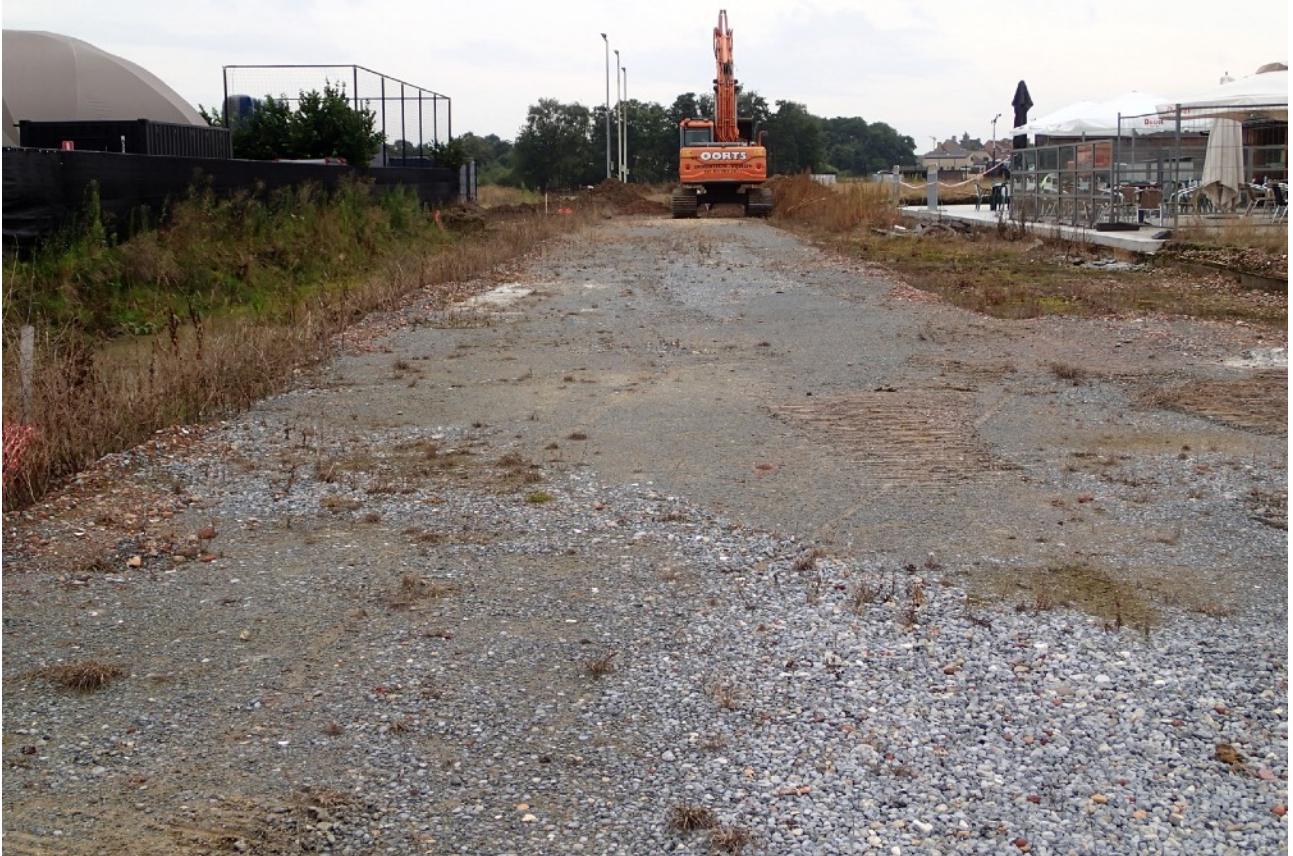
Fig. 5 Zicht op het onderzoeksgebied vanuit het oosten, voor de aanleg van werkput 2. Links de uitgraving die de aanleg van werkput 1 op de oostelijke helft van het terrein overbodig maakte, rechts de strook waarbinnen geen bodemingrepen toegelaten zijn omwille van de stabiliteit van de ondergrondse schietstand. Centraal de verhardingen die dienst doen als parking. © Fodio 17-08-2021
