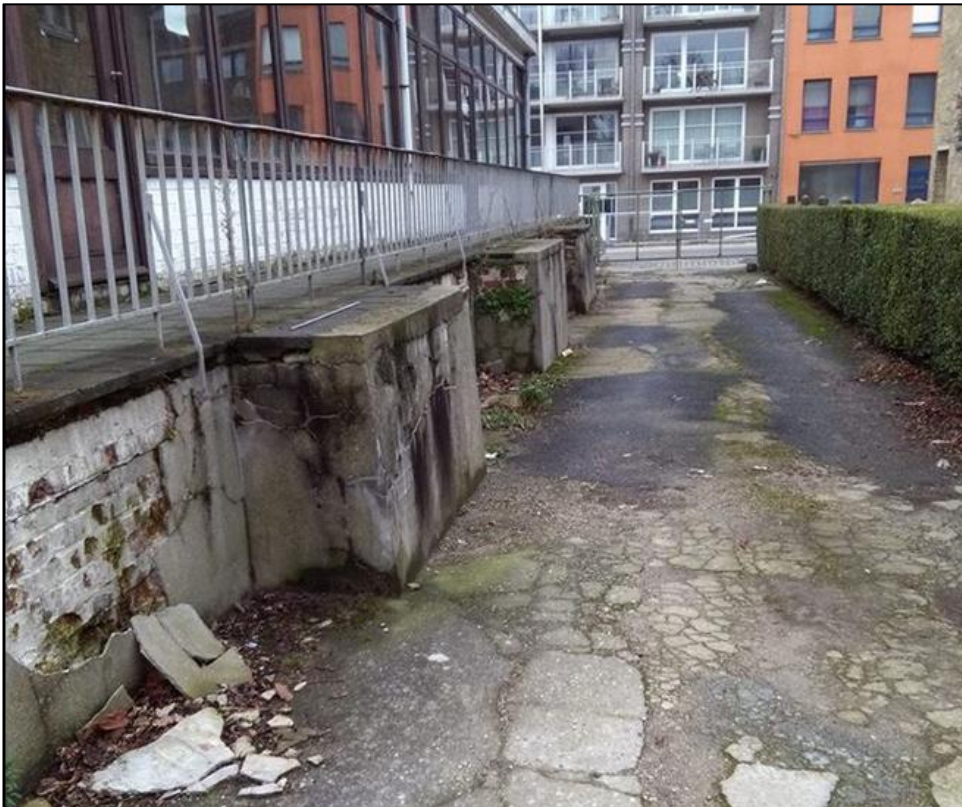
Figuur 42: buitenzijde van de bunkergang – foto genomen vanaf de noordzijde
