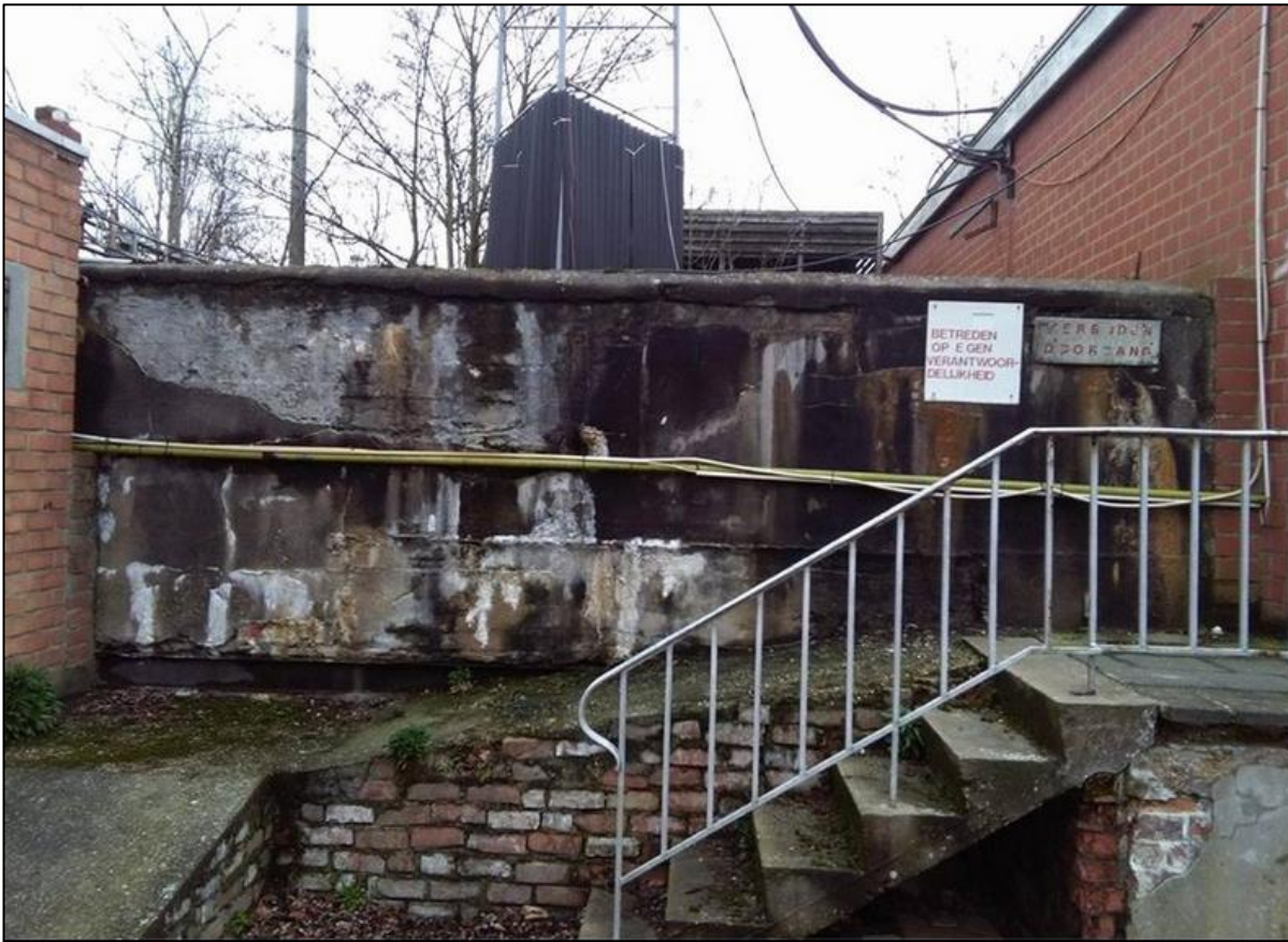
Figuur 25: westelijke zijde van de bunkermuur en de bunkergang
