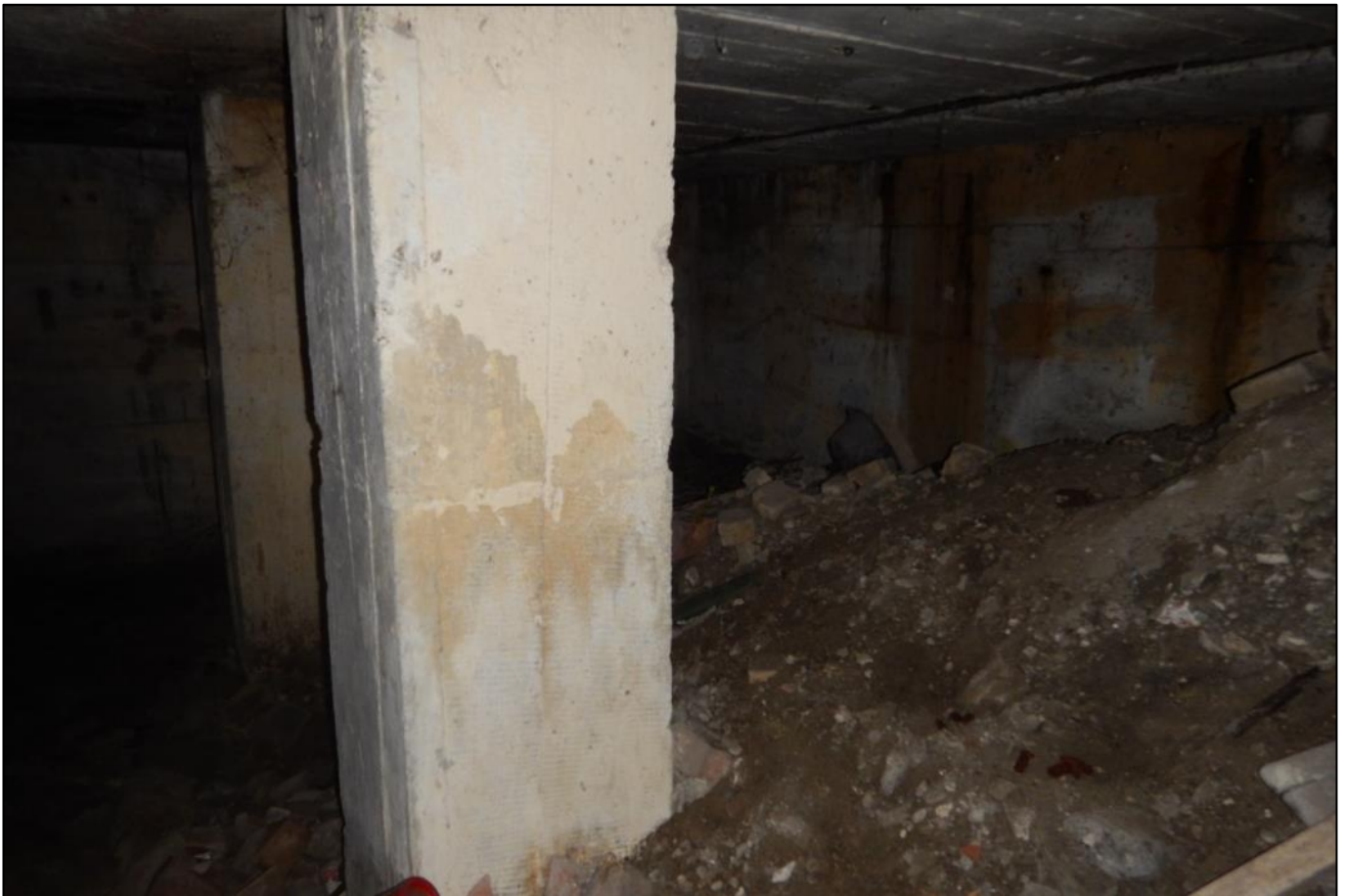
Figuur 38: De westelijke muur van de bunker met weergave van de steunpilaren
