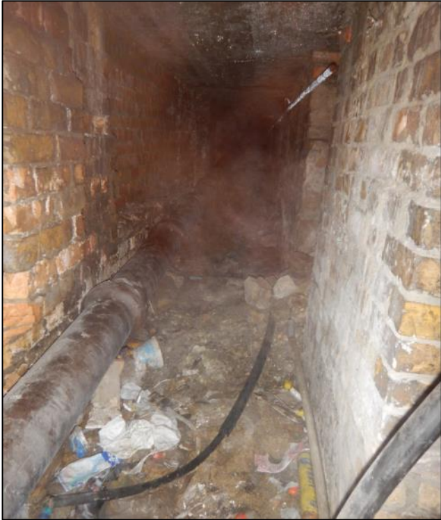
Figuur 40: Bunkergang - foto genomen vanaf de zuidzijde
