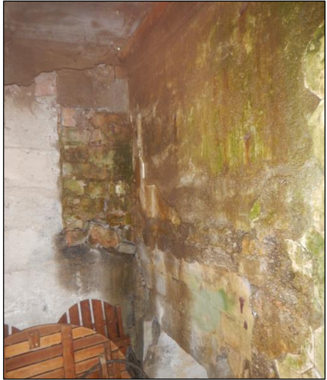
Figuur 32: onderaan noordingang bunker – noordelijke bunkermuur
