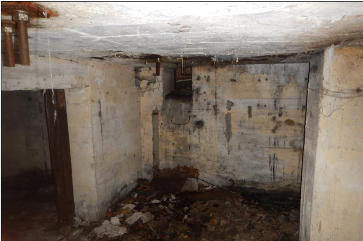
Figuur 33: Bunker (foto genomen vanaf de noordzijde)
