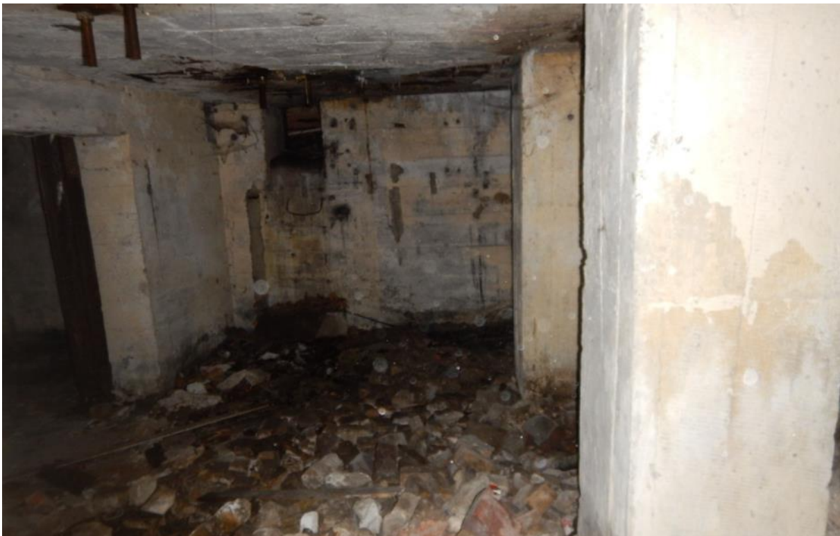
Figuur 34: Bunker (foto genomen vanaf de noordzijde)
