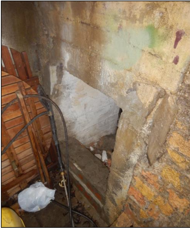
Figuur 31: Noordingang bunker
