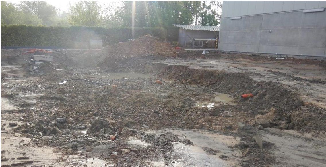
Figuur 11: Werkfoto kelder in niet onderzoekbare zone 1
