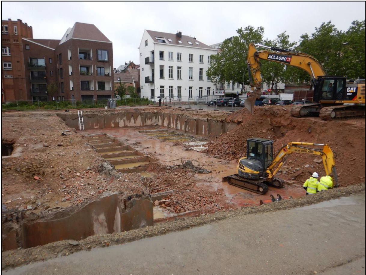
Figuur 2 Foto genomen op 21/06/2021 van de afbraakwerken van het Sint-Pietersziekenhuis, met zicht vanuit het oosten op de kelders onder de voormalige noordwestelijke vleugel van het ziekenhuis (© Stad Leuven). De Brusselsestraat bevindt zich rechts.
