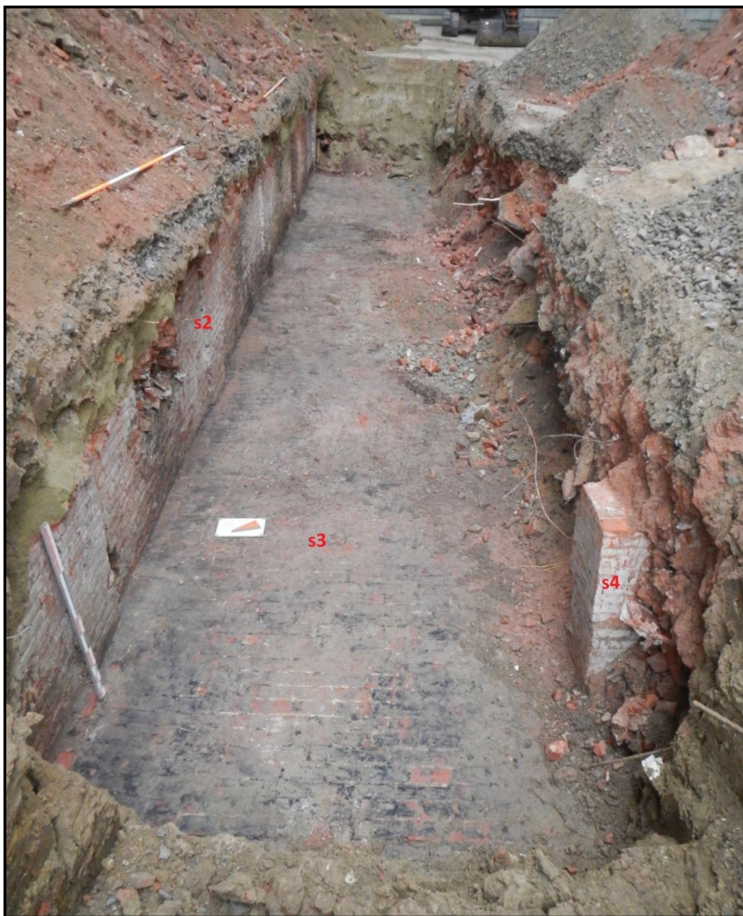
Figuur 48 Proefsleuf 3. Overzicht kelder 19 de -eeuwse gasthuis (bron: LINTEN e.a., 2015).
