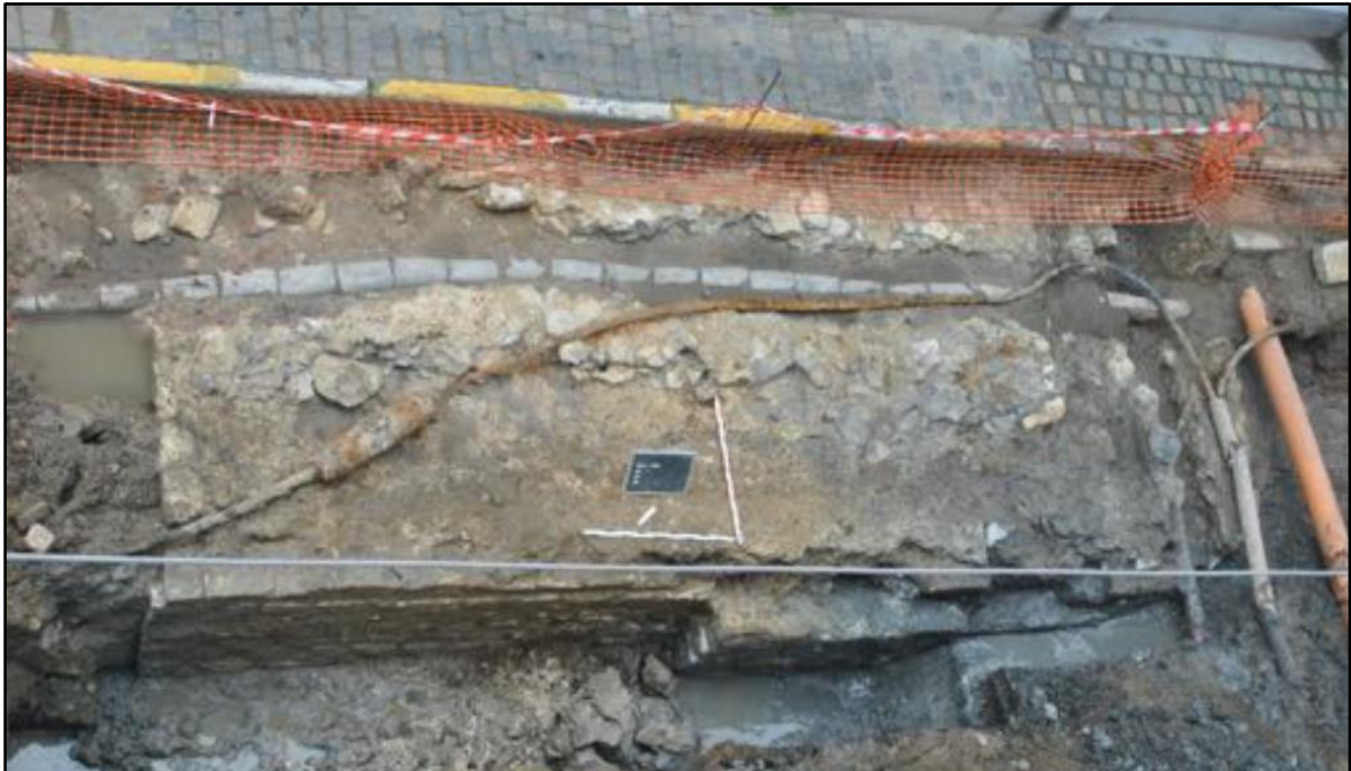
Figuur 52 Bovenaanzicht van de fundering van de stadspoort met duidelijk zichtbaar de verspringing (bron: SMEETS, 2015, p. 46 fig. 4.9).
