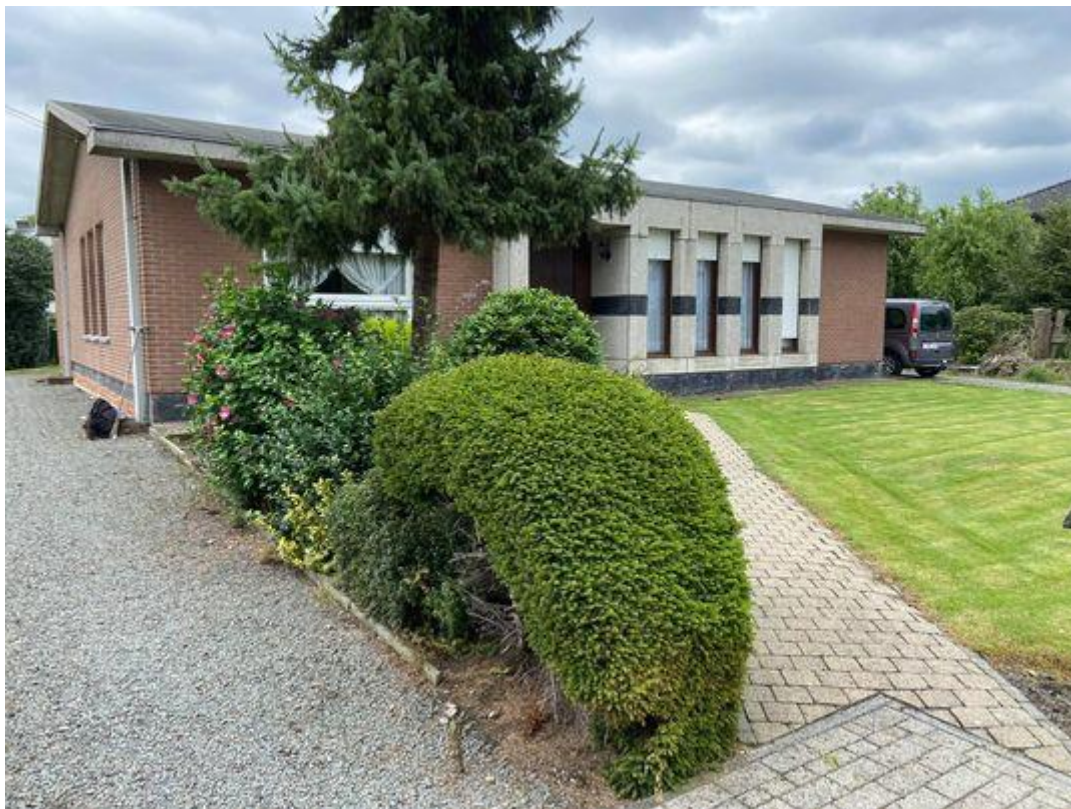
Figuur 26: Zicht op de bestaande woning anno 2021.
