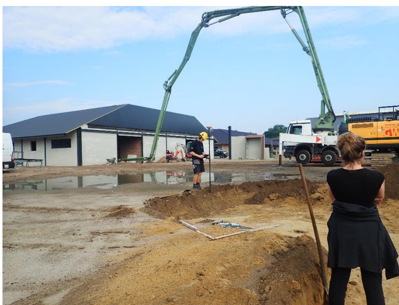
Figuur 29: Zicht op enkele van de aanwezige structuren (© J. Verrijckt Bvba).
