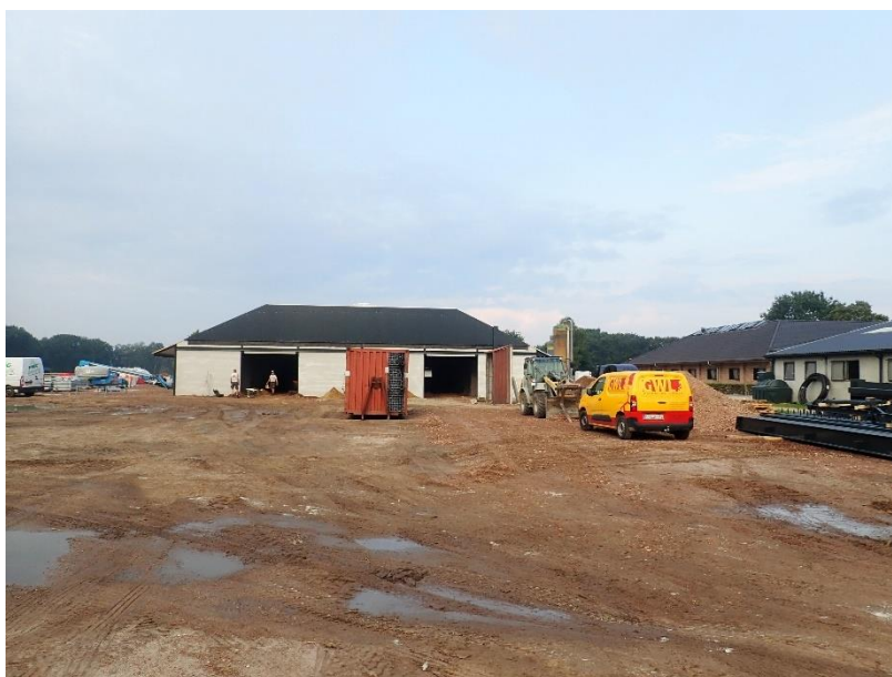
Figuur 28: Zicht op enkele van de aanwezige structuren (© J. Verrijckt Bvba).
