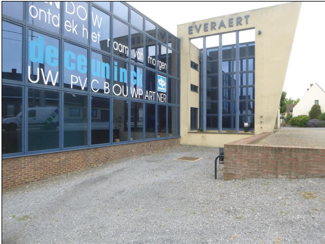
Figuur 9: De positie van de ondergrondse watercitern (ABO nv 2021).
