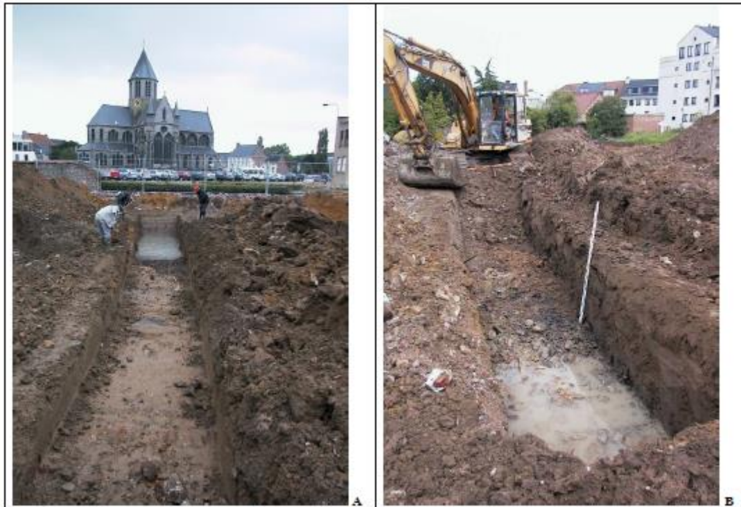
Figuur 22: sleuf 5 en sleuf 6, bij de uitgraving van sleuf 6 wordt de situering van de kasteelgracht duidelijk daar de vulling onmiddellijk onderstroomt (bron: AMEELS, V. 2014 figuur 16).
