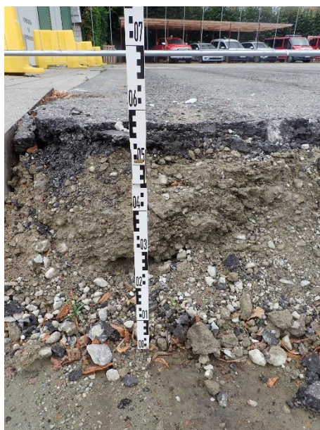
Figuur 18: Weergave van verharding ter hoogte van de huidige brandweerkazerne en ter hoogte van de voormalige brandweerkazerne. Op deze afbeeldingen is duidelijk te zien dat de reeds bestaande verharding van ca. 50 cm dik is opgebroken (© J. Verrijckt Bvba).
