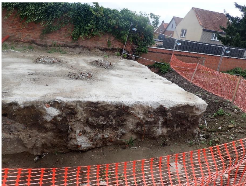
Figuur 21: Betonnen plaat van ca. 1 m (© J. Verrijckt Bvba).
