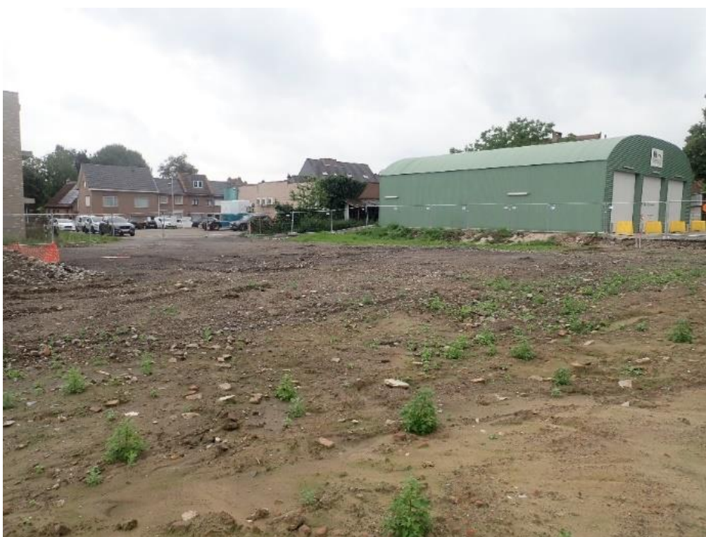
Figuur 17: Weergave van het terrein vanuit noordoostelijke hoek richting het zuidwesten (© J. Verrijckt Bvba).
