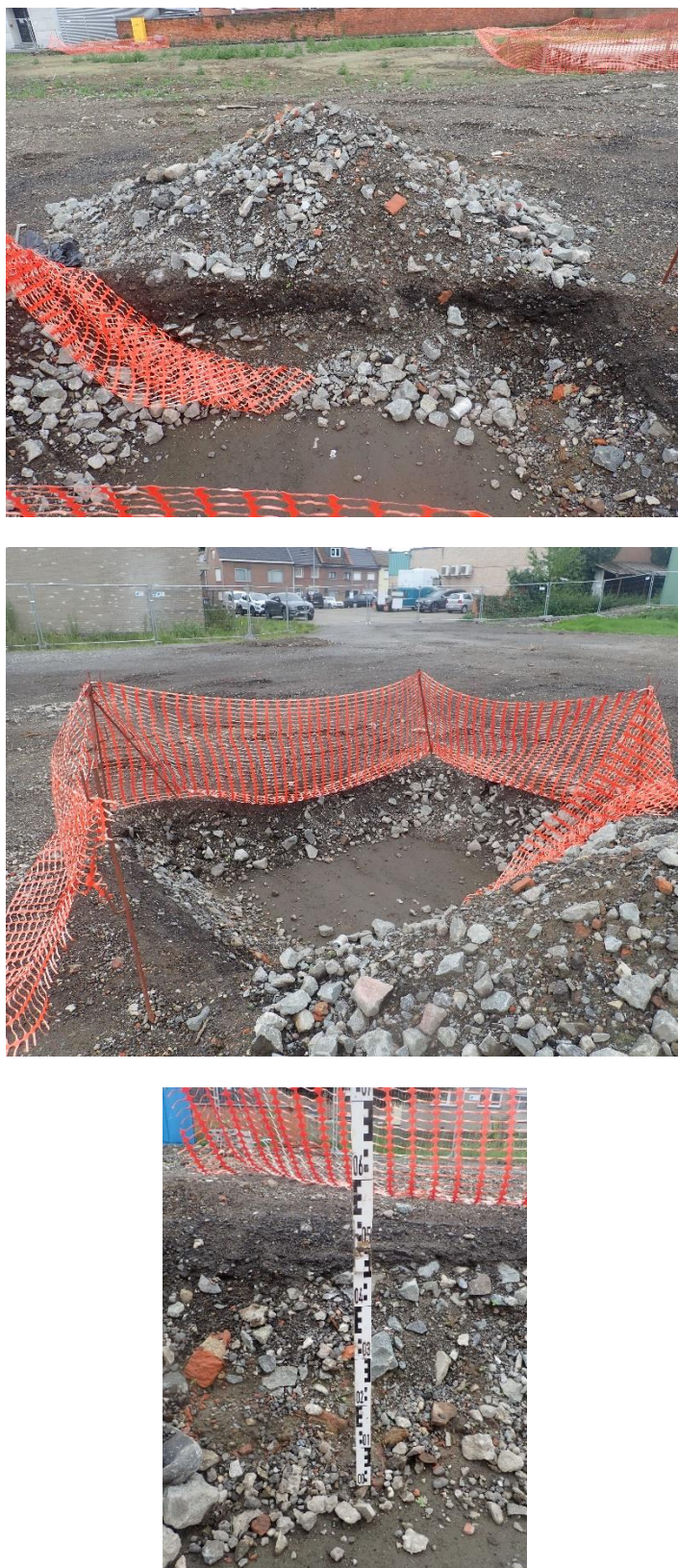
Figuur 19: Locatie waar lokaal de steenslag nog eens extra is verwijderd voor het zetten van boring 7 (© J. Verrijckt Bvba).
