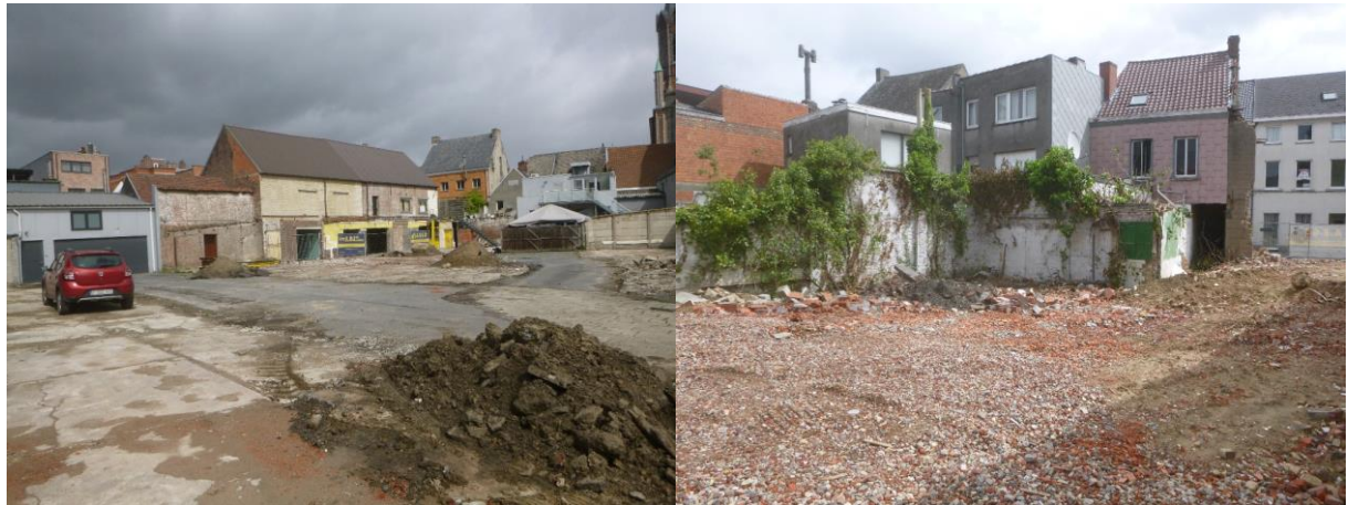
Figuur 6: Omgevingsfoto nabij BP6, genomen in noordwestelijke richting (links) en ten zuidwesten van BP7 genomen in noordoostelijke richting (rechts).
