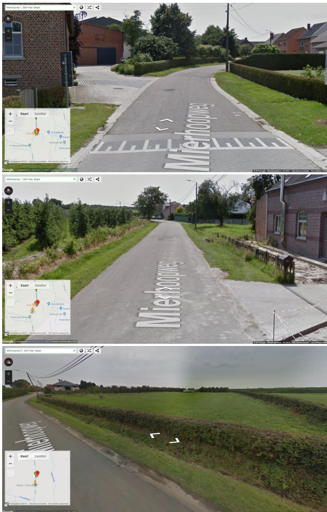
Figuur 5: Toestand van het projectgebied in oktober 2013, van boven naar onder: betonverharding in de Grotestraat, combinatie asfaltverharding en klinkerverharding op het kruispunt van de Grotestraat naar de Mierhoopweg, asfaltverharding met riolering tot en met Mierhoopweg 1, asfaltverharding en grachten in de Mierhoopweg en het geplande terrein voor grondverbetering. (Bron: Google Steet View, 2018).
