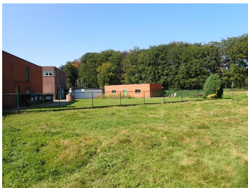
Figuur 13: Weergave van de bebouwing. Foto genomen vanuit oostelijke hoek. (© J. Verrijckt Bvba). 17
