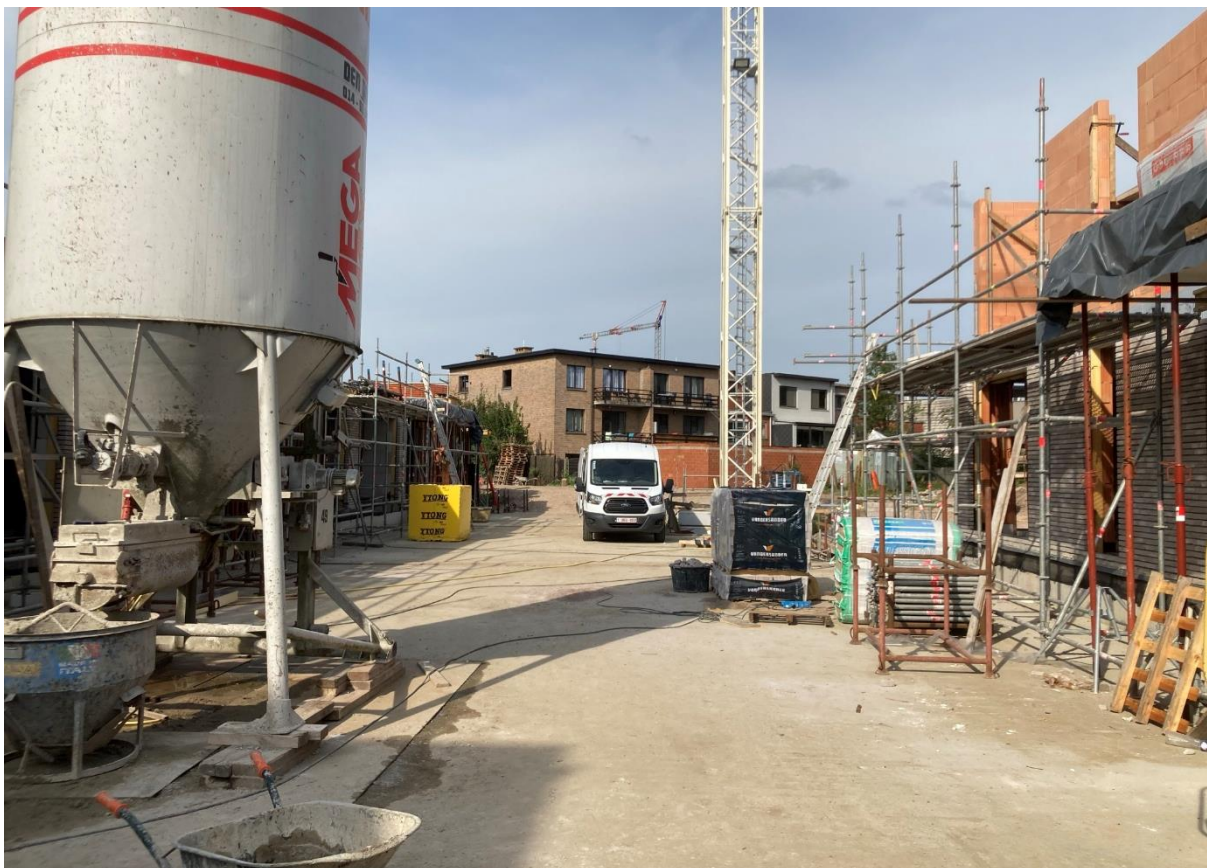
Figuur 12: Zicht op de gerealiseerde bebouwing met onderkeldering, gefotografeerd in noordelijke richting. (Bron: ABO nv 2021).
