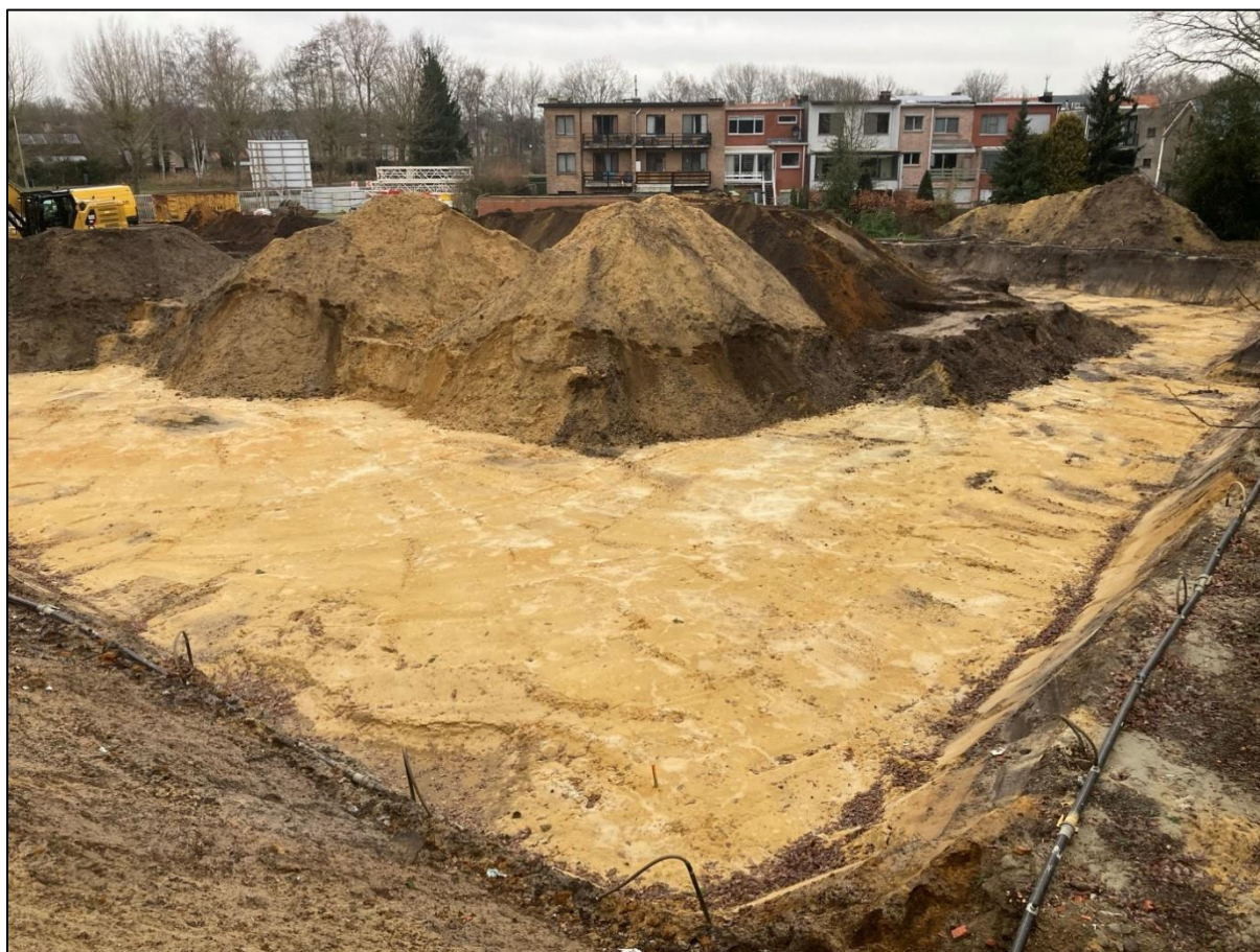
Figuur 7: Zicht op de oostelijke en grootste bouwput, foto richting het noordwesten. (Bron: ABO 2021).
