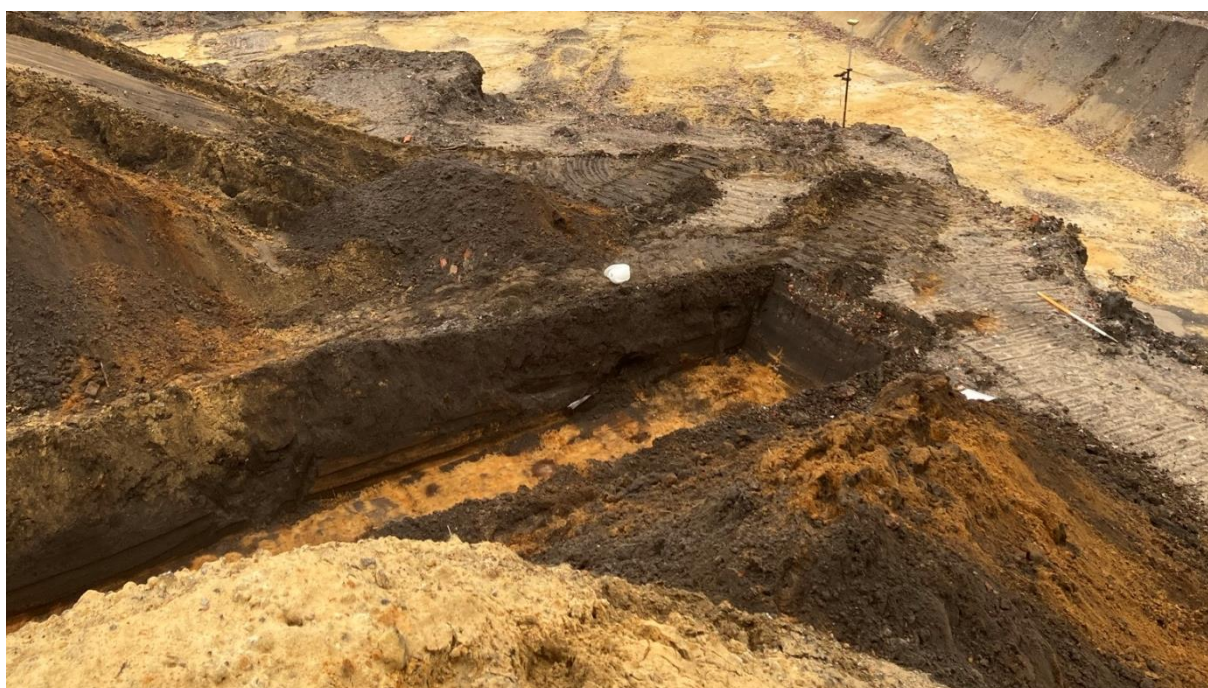
Figuur 27: Locatie van werkput 5 tussen de zandhopen en de bouwput. (Bron: ABO nv 2021).
