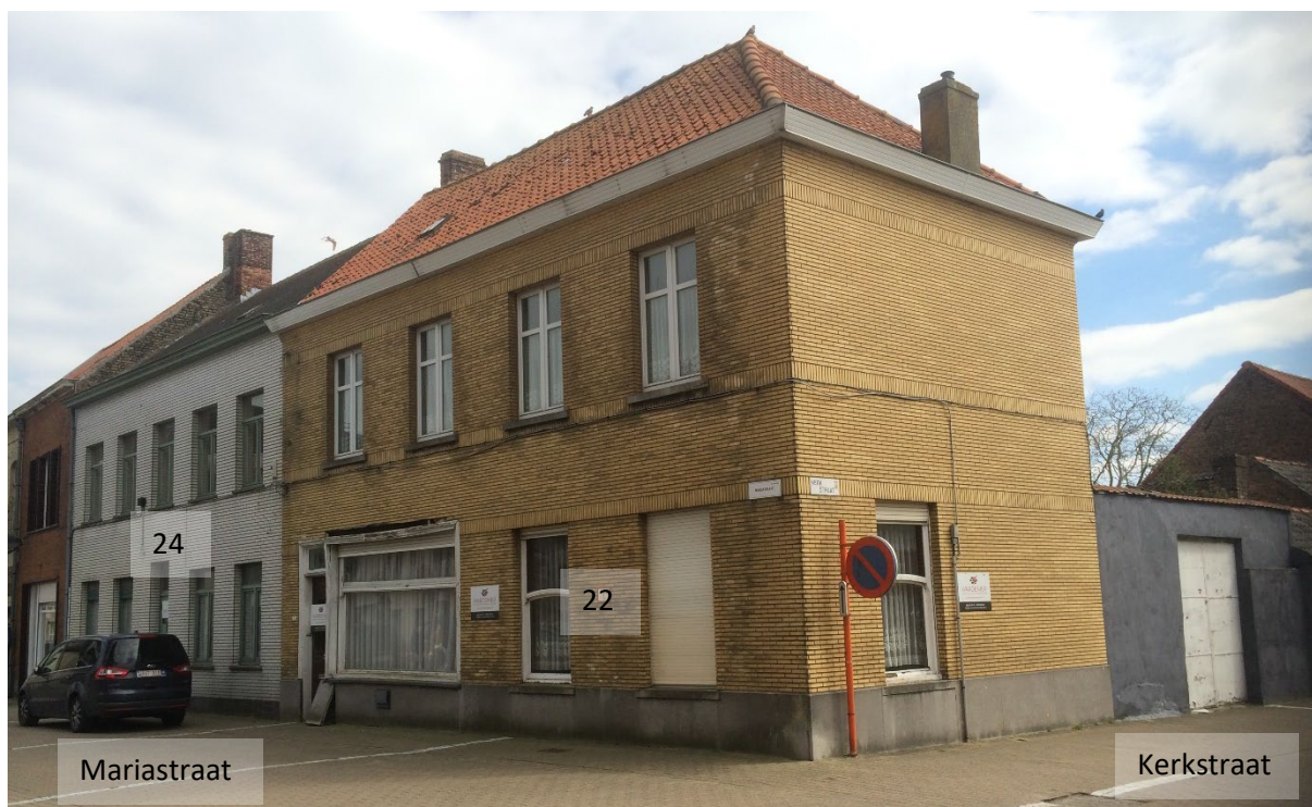
Figuur 5. De bestaande toestand van de gebouwen. Links: nr. 24, rechts: nr. 22 (bron: opdrachtgever).
