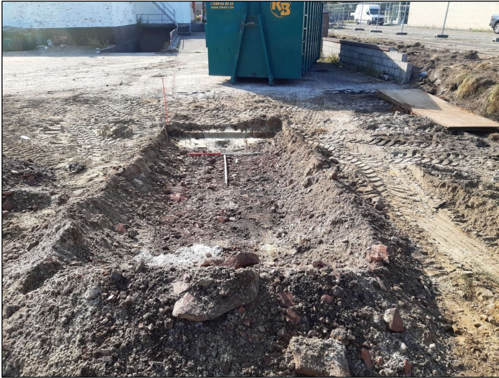
Figuur 19: Verstoorde ondergrond in zuidelijke proefput ter hoogte van werkput 2
