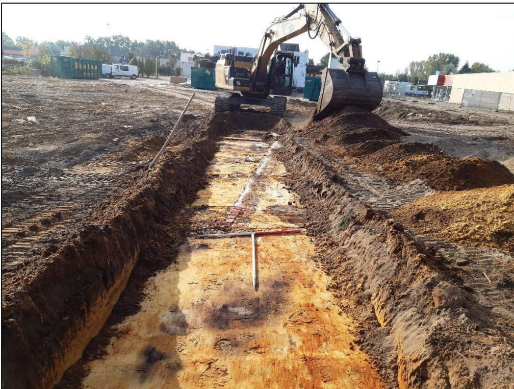
Figuur 18: Funderingen in werkput 2
