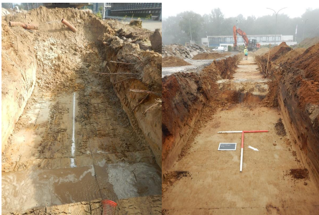
Figuur 32: Links: Fotografische opname van de aangetroffen elektriciteitsleiding (rode buis op voorgrond) en de riolering in sleuf 3. Rechts: Fotografische opname van de rioleringsbuis die sleuf 2 doorsnijdt.
