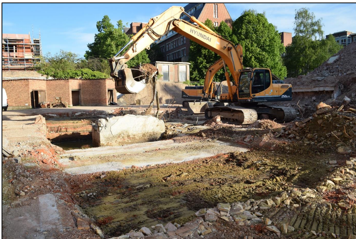
Figuur 40 Uitbraak van de kelder van het voormalige gebouw ter hoogte van het plangebied, gezien vanuit het oosten. Achteraan zijn de garageboxen te zien die deels behoren tot het plangebied. Foto genomen op 14/05/2019 (bron: Studiebureau Archeologie).
