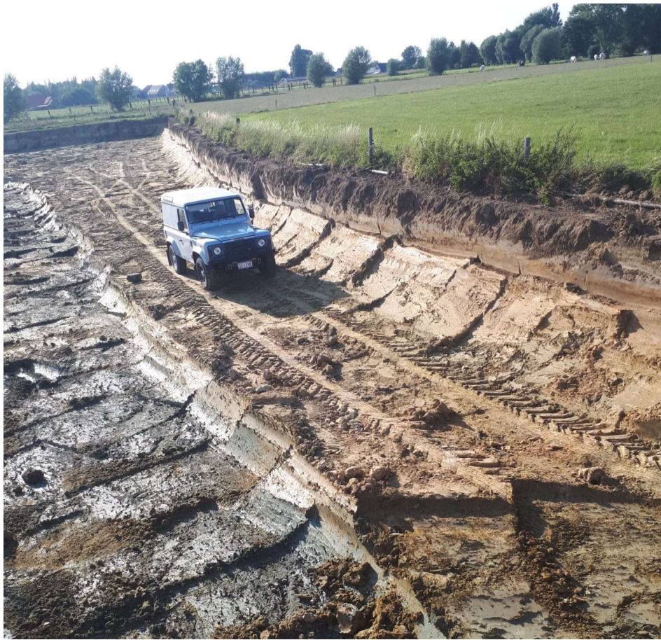
Figuur 7: Zicht op de recente afgraving langs de beek. 9
