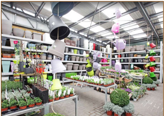
Foto 6: Stalen constructie en betonklinkers in de achterzijde van het hoofdgebouw.
