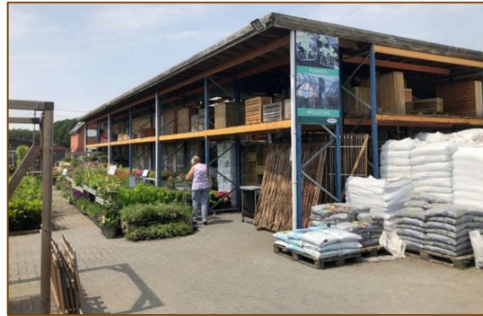
Foto 8: Constructie 2 – overkapte palletstelling. Verharding in de hangars is betonplaat.
