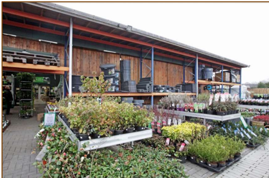
Foto 10: Constructie 2 – overkapte palletstelling. Verharding in betonklinkers en waterdoorlatende klinkers.
