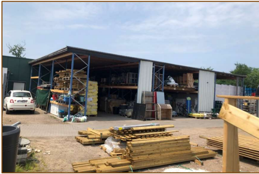
Foto 8: Constructie 2 – overkapte palletstelling. Verharding in de hangars is betonplaat.
