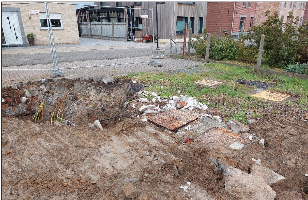
Figuur 2 Zone met rioleringscollectoren in de noordwestelijke hoek van het terrein aan de Huttestraat.
