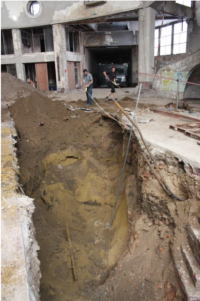
Foto 5: Zicht op de verstoorde pakketten onder de huidige vloerplaat van het Wintercircus. De nieuwe projectzone situeert zich in de achtergrond van de foto (Stad Gent, De ZwarteDoos, Stadsarcheologie Gent)
