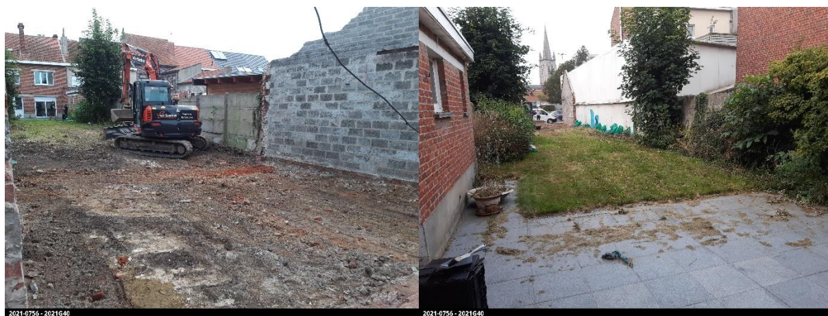
Figuur 5: Tereinsituatie voor de start van het onderzoek
