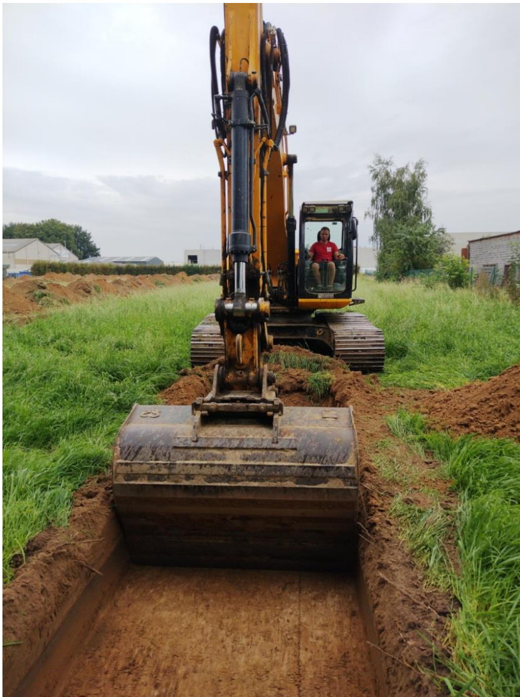
Figuur 16: Gebruikt materiaal – Rupskraan met platte graafbak van 1,80m breed.
