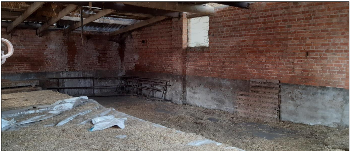
Figuur 19 : Zicht op binnenkant westelijke stal met ondergrondse mestkuil, gezien vanuit het zuidoosten.
