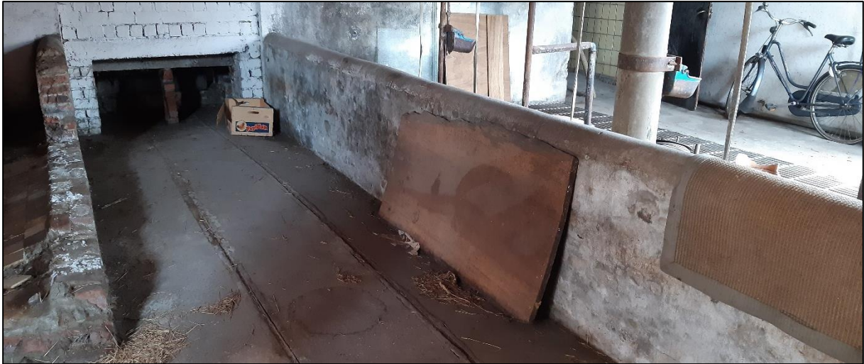
Figuur 21 : Zicht op de binnenkant van de centraal gelegen stal ter hoogte van de bietenkelder van ongeveer 1,5 m diepte, gezien vanuit het zuidwesten.
