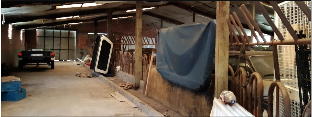
Figuur 18: Zicht op binnenkant noordelijke stal, gezien vanuit het zuiden.
