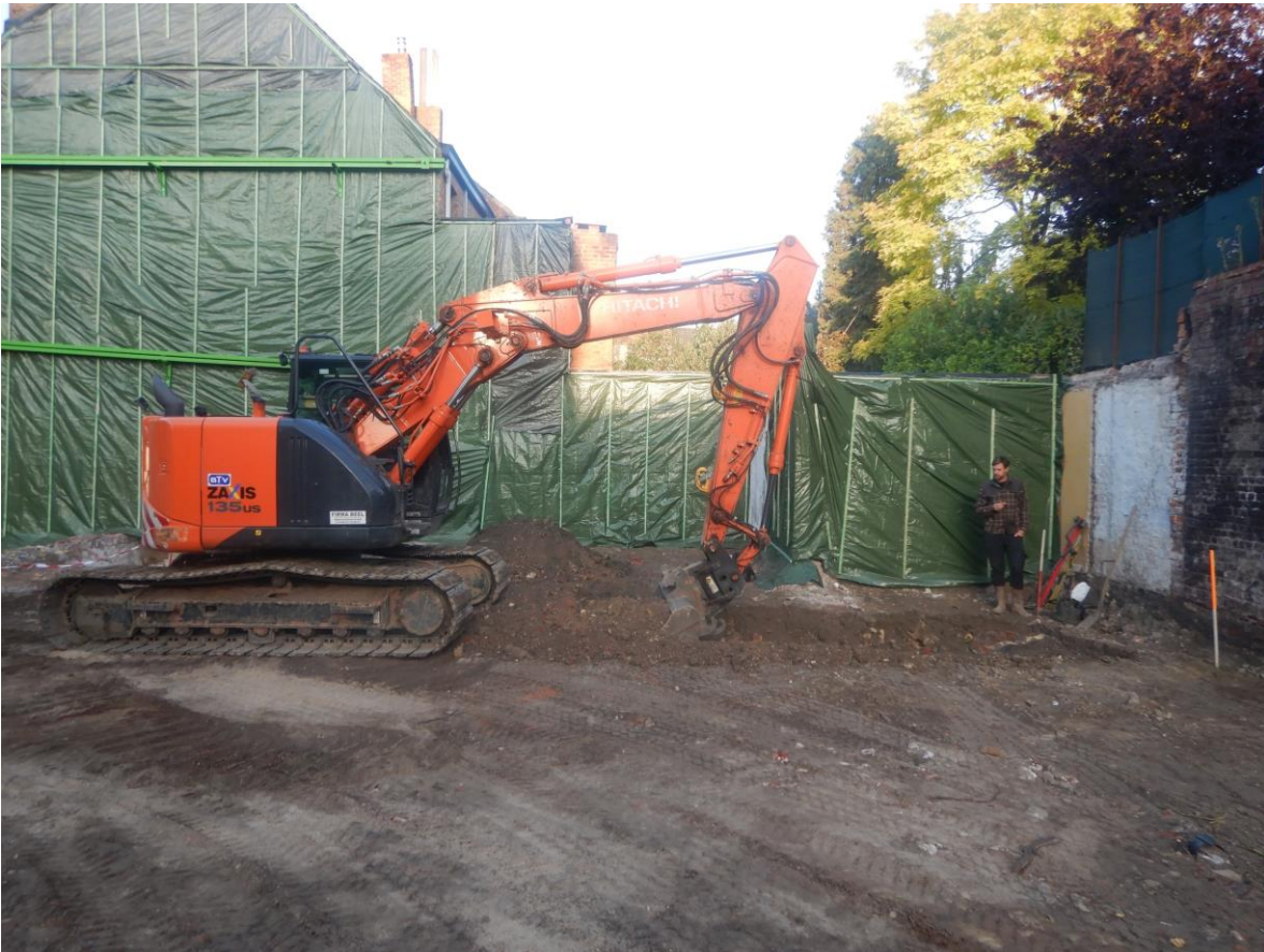
Figuur 7: Begin van het uitgraven van de proefput onder de goedkeurende blik van de veldwerkleider.
