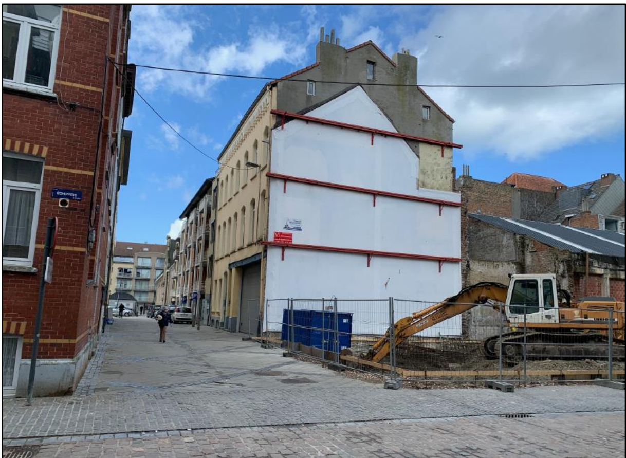
Figuur 10 Beeld vanuit het zuidoosten op de graafwerken op het terrein (bron: initiatiefnemer).
