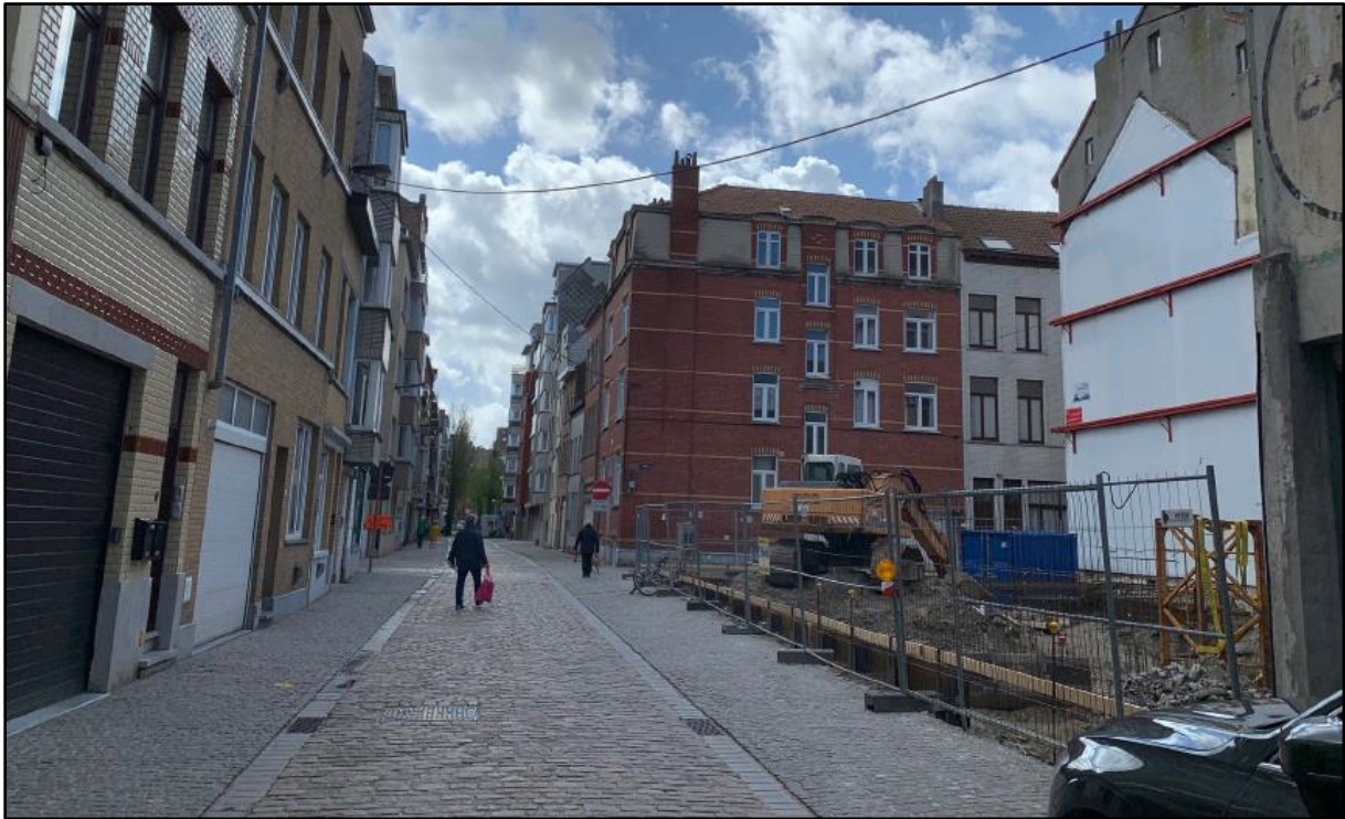
Figuur 9 Beeld vanuit het noorden op de graafwerken op het terrein (bron: initiatiefnemer).
