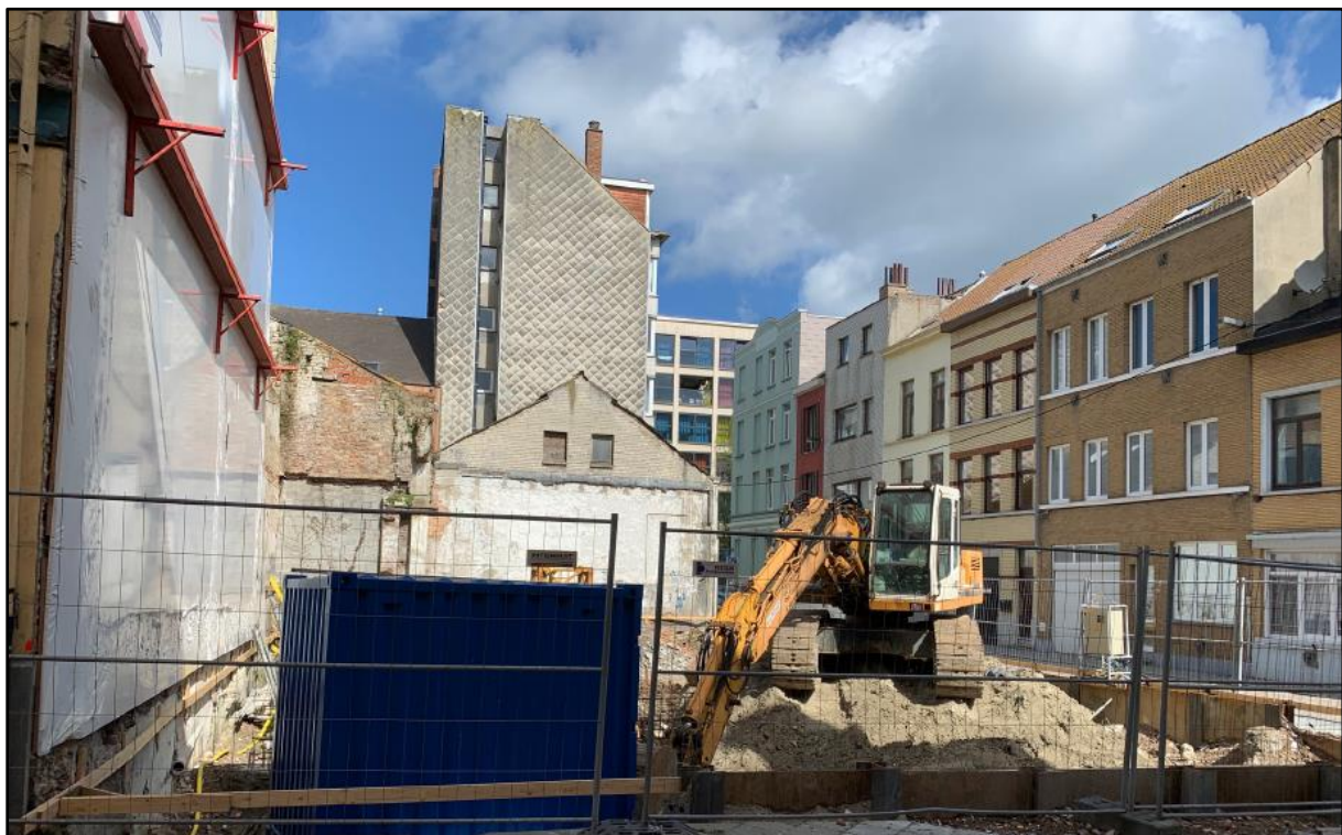
Figuur 8 Beeld vanuit het zuiden op de graafwerken op het terrein (bron: initiatiefnemer).
