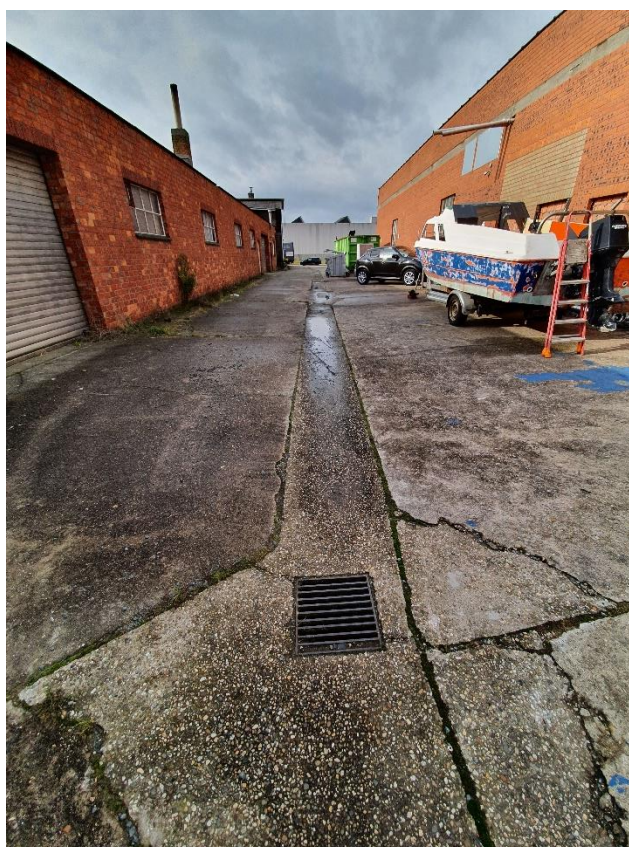
Figuur 17: Zicht op het terrein tussen de gebouwen achter nrs. 47 (links) en 45 (rechts), waar duidelijk een nutsleiding doorloopt (© J. Verrijckt)
