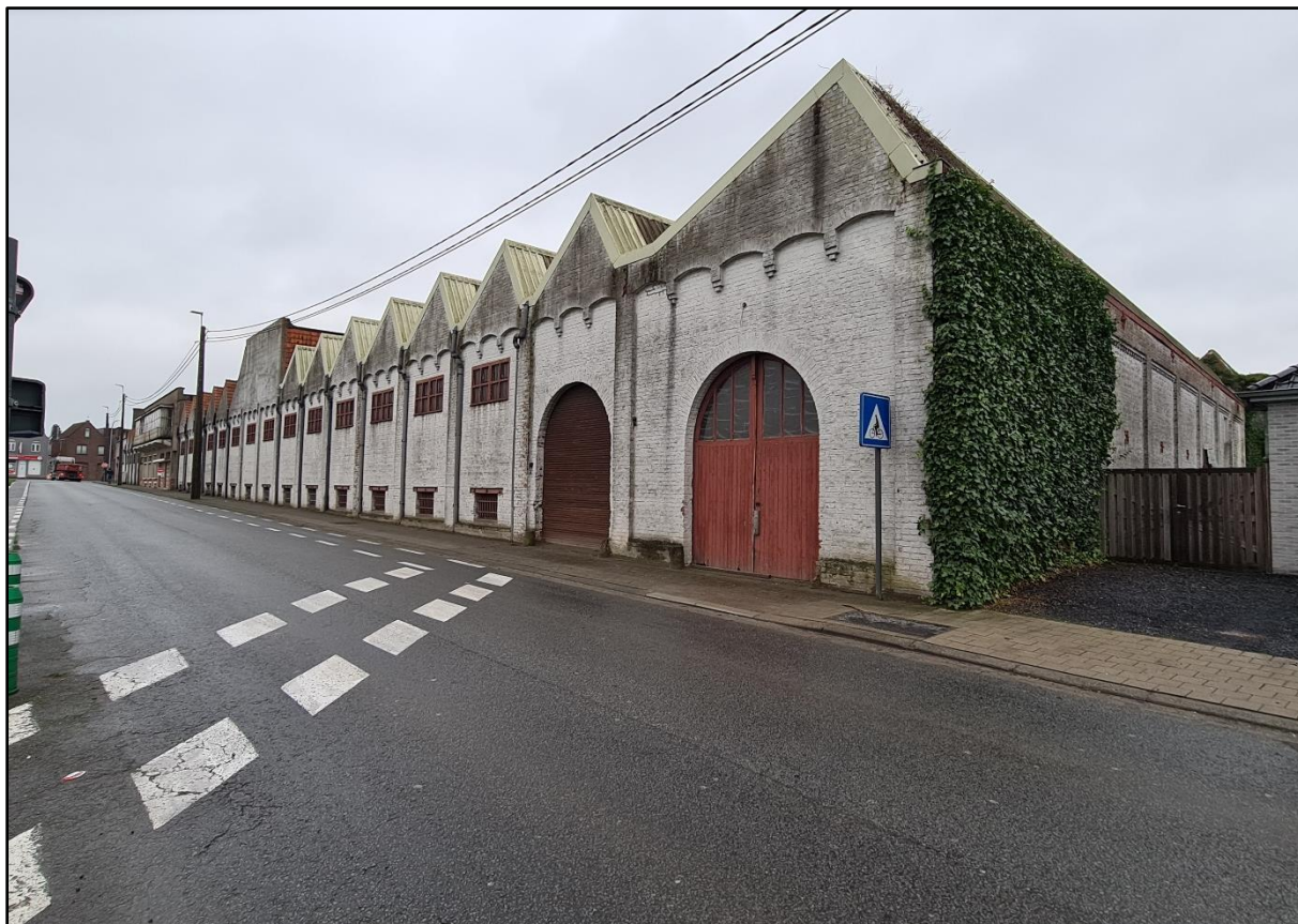
Figuur 4 Zicht op de bebouwing langs de Waregemstraat, gezien vanuit het noorden (bron: initiatiefnemer).
