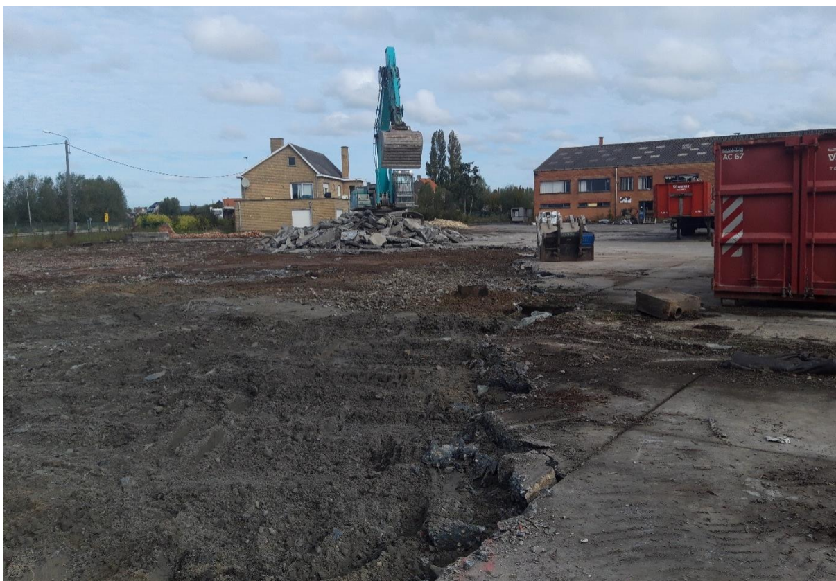
Figuur 20: Zicht op het uitbreken van de betonvloer binnen fase 1.
