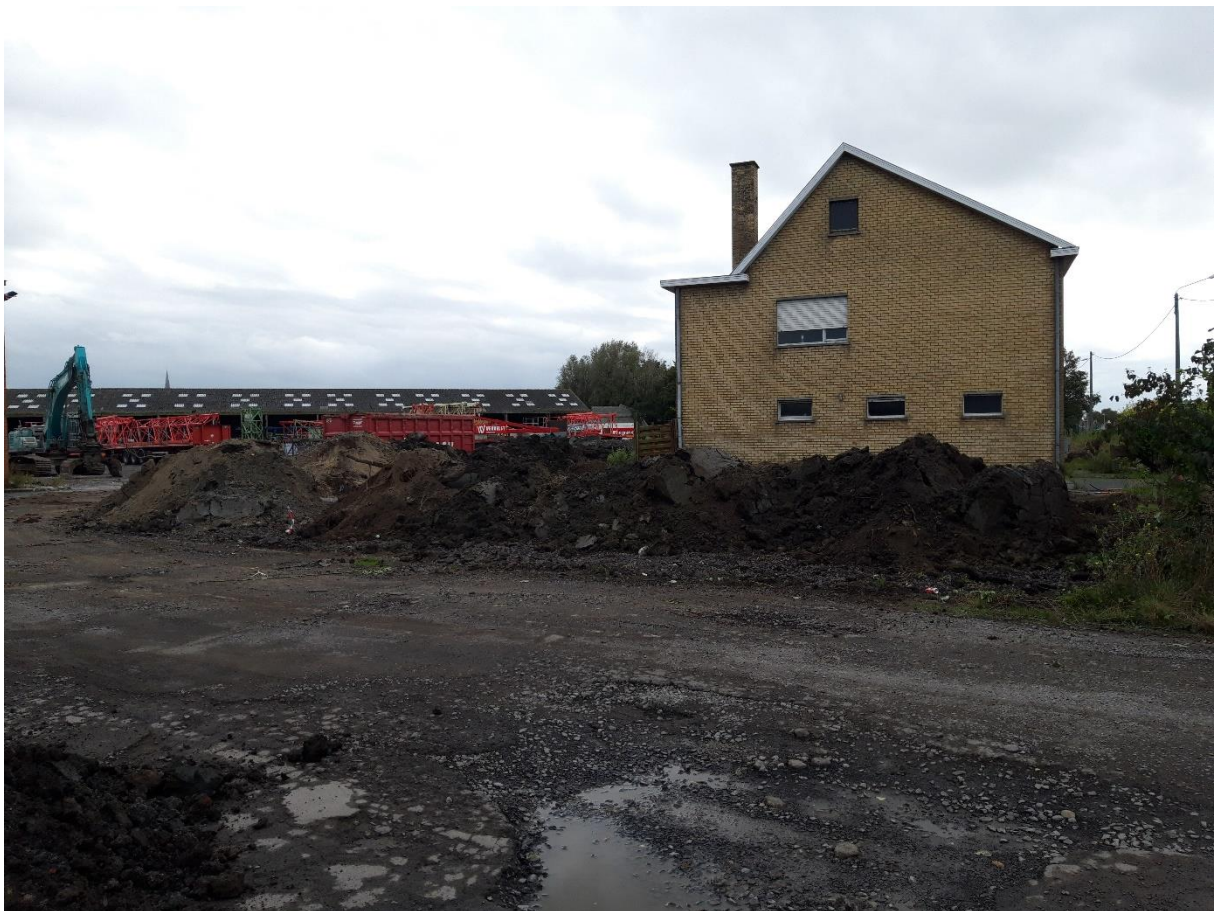
Figuur 23: Zicht op het huis en de oprijlaan die niet mochten worden afgebroken. Centraal op de foto is sleuf 7 te zien.
