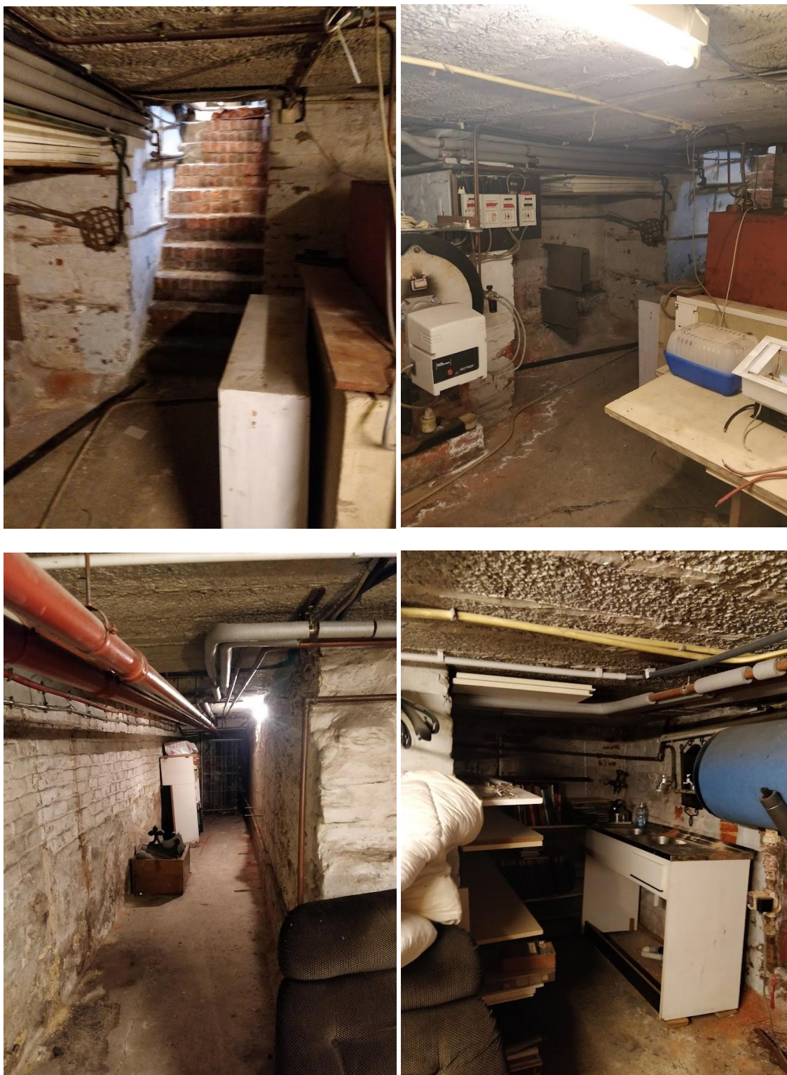
Figuur 14: Bestaande kelder (erfgoeddienst IOED Oost-Haspengouw & Voeren)
