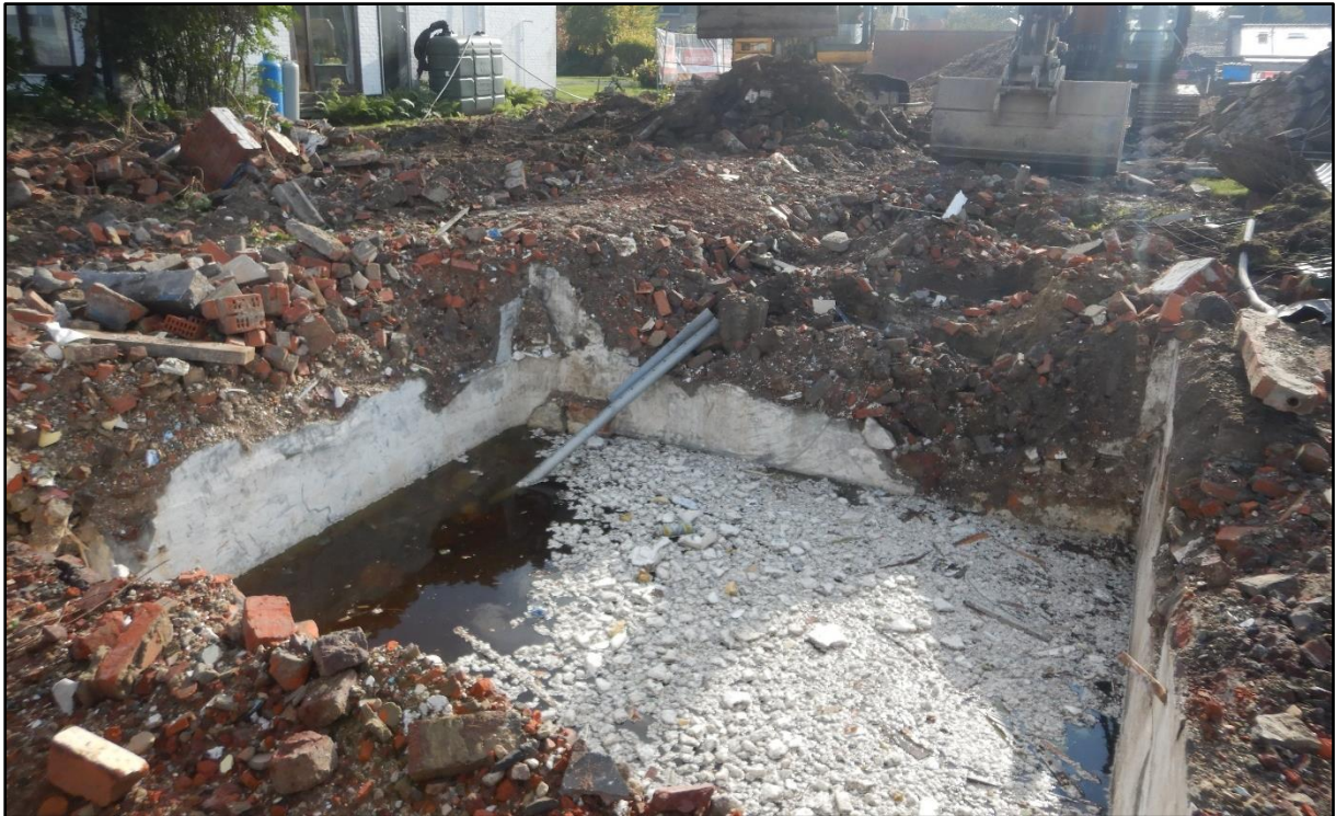
Figuur 5 De aanwezige kelder in het noordoosten van het terrein.
