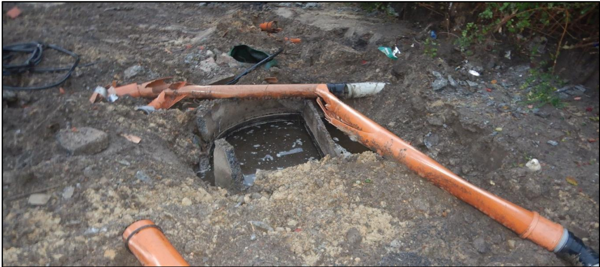
Figuur 3 Een van de aanwezige beerputten op het terrein.
