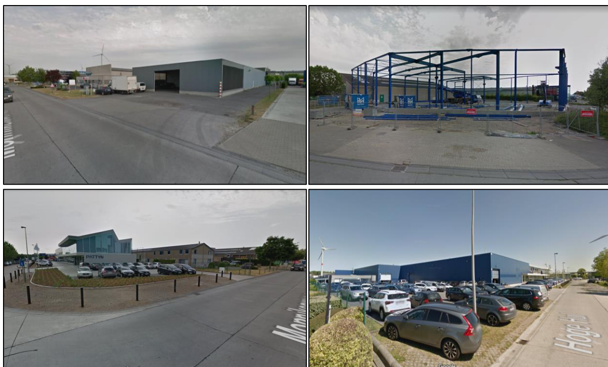
Figuur 4: Bestaande toestand van het projectgebied getrokken richting het zuidoosten (linksboven), zuidwesten (rechtsboven), noordwesten (linksonder) en noordoosten (rechtsonder) (Google Streetview, 2021)
