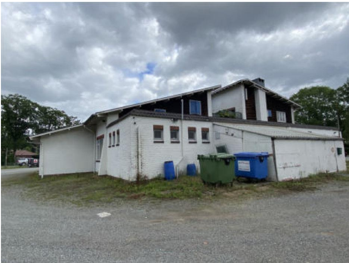
Figuur 4: Zicht op de bebouwing binnen het onderzoeksgebied (STETO 2021, bijlage 5)
