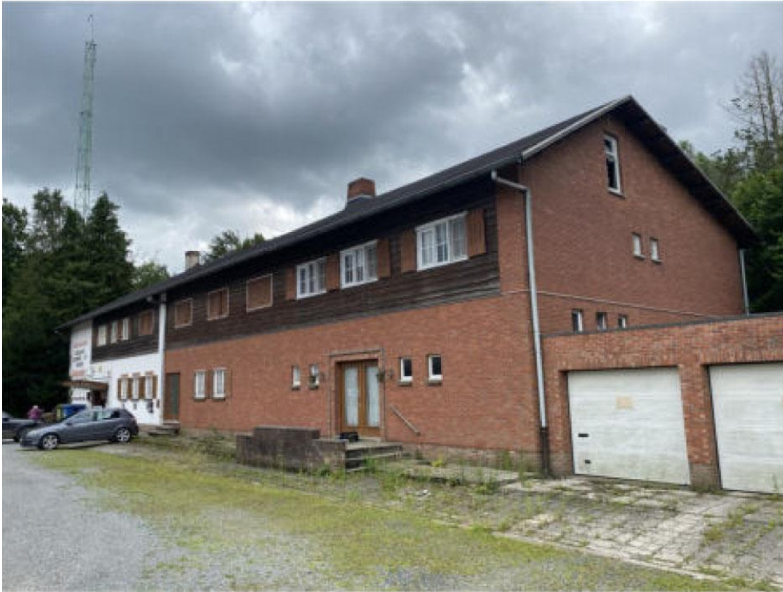
Figuur 3: Zicht op de bebouwing binnen het onderzoeksgebied (STETO 2021, bijlage 5)
