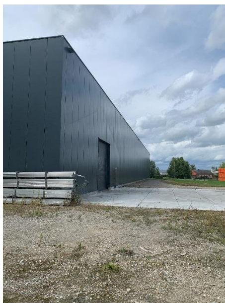
Figuur 3: Voorzijde gebouw – kijkrichting N - Z
